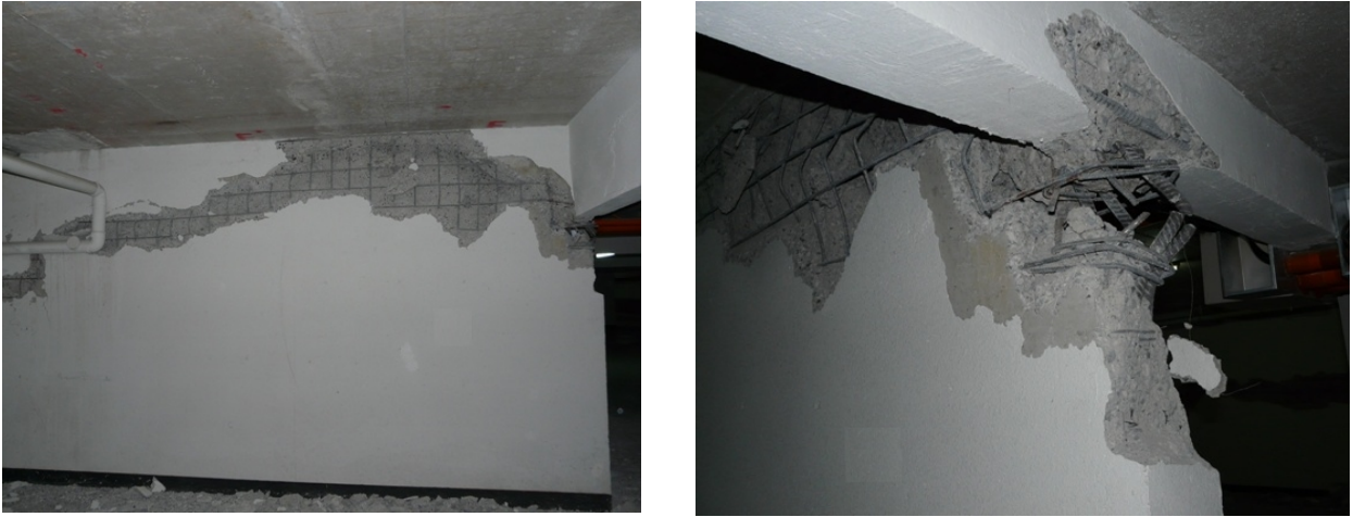
Figura 3.11 Muro eje F primer subterráneo, Edificio B.
