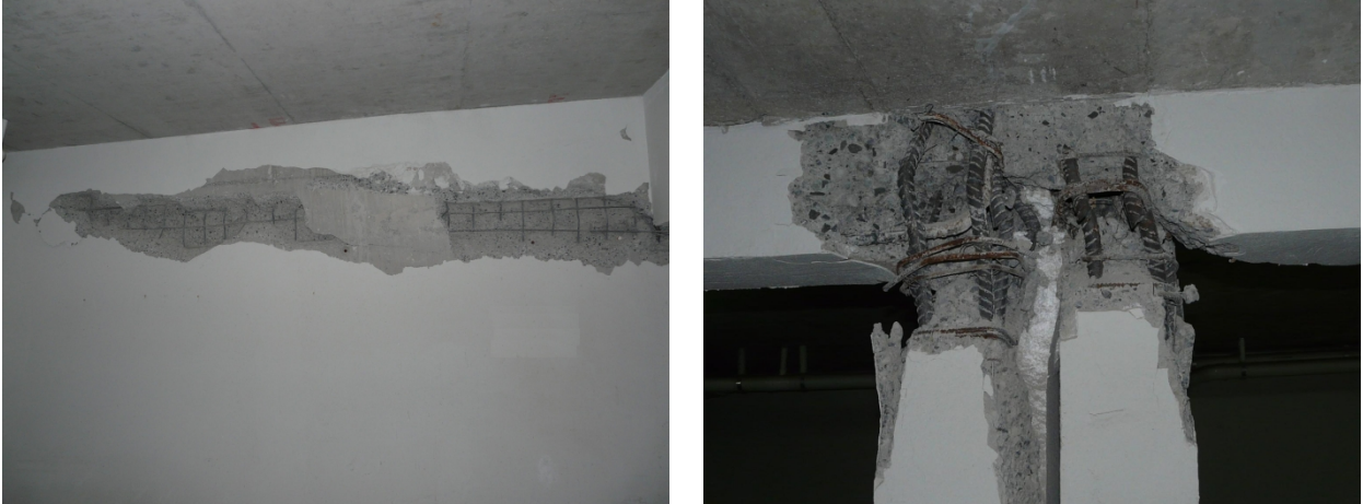
Figura 3.13 Muros ejes M y N primer subterráneo, Edificio B.
