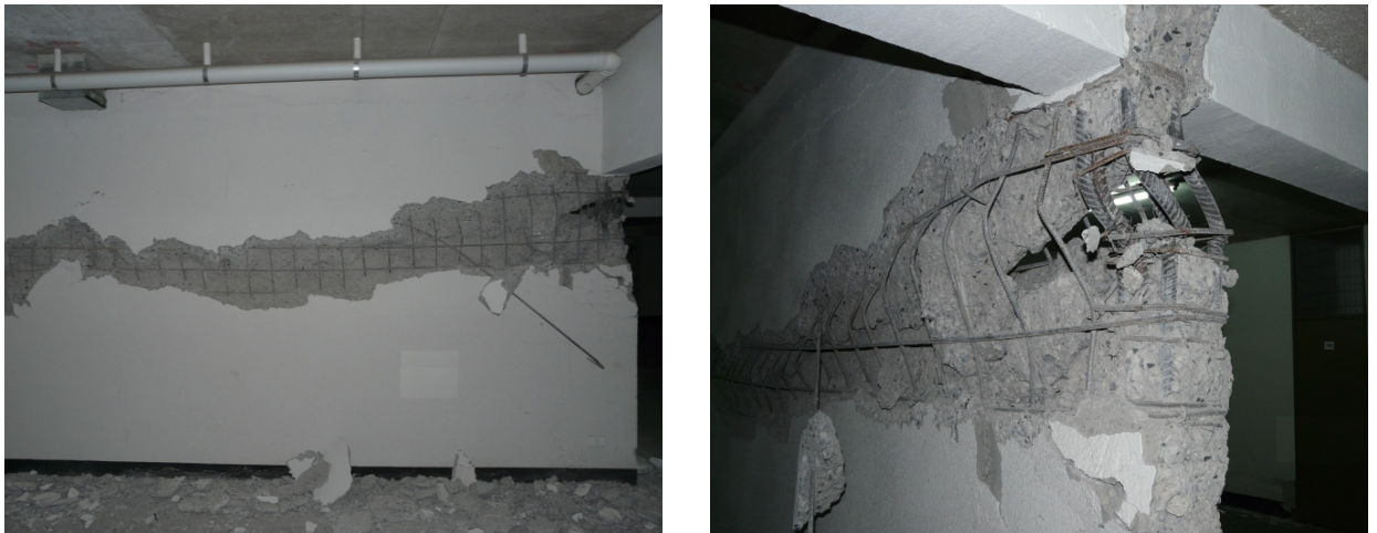
Figura 3.12 Muro eje J primer subterráneo, Edificio B.
