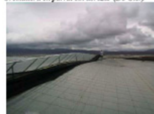
Montaje Ventana en Parral
