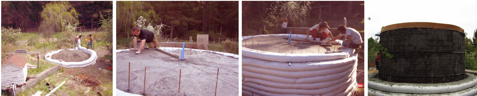
Imágenes de la construcción de una sistema de ferrocemento para almacenar el agua lluvia captada dese el techo de una casa, en la Ecoescuela “El Manzano”, Cabrero, XIII región.
