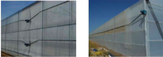
Banda lateral con motor-reductores y brazos telescópicos (De Gier)
