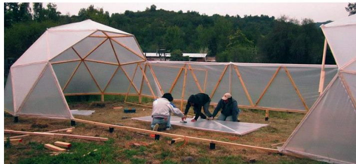
Materialidad: Estructura de pino radiata, cubierta de polietileno.
