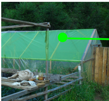
Invernadero tipo capilla , con una de sus caras laterales de mayor longitud orientada acia el Norte, para mayor aprovechamiento del sol.
