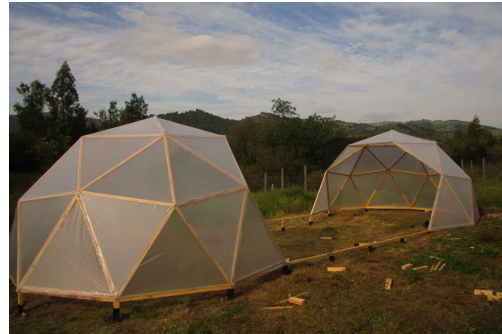
Proceso de construcción
