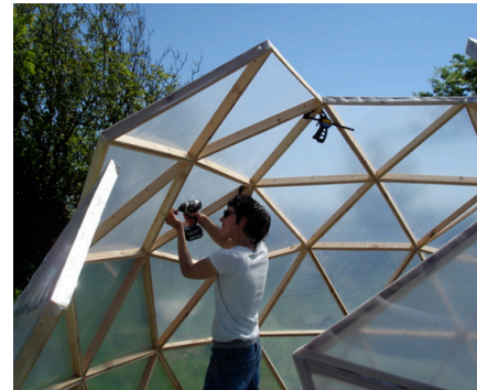
Construcción del módulo triangular con el material plástico de la cubierta.
