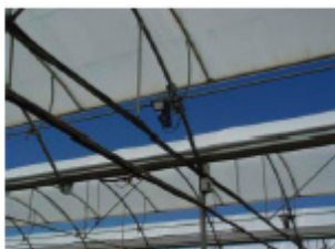
Ventilación automática con Motor-reductor G1W30 (De Gier)
