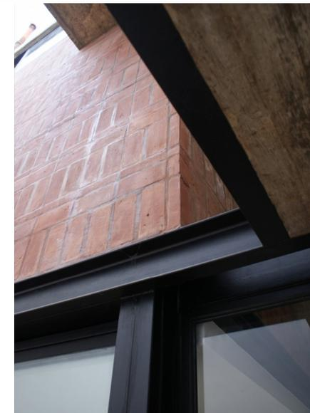
Ejemplo de Pilar y viga en acero con muros soportantes de ladrillos y losas de hormigón.
