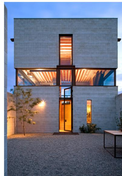
Casa Outpost, Olson Kundig Architects, EE.UU. Estructura en acero con muros de bloques prefabricados de concreto
