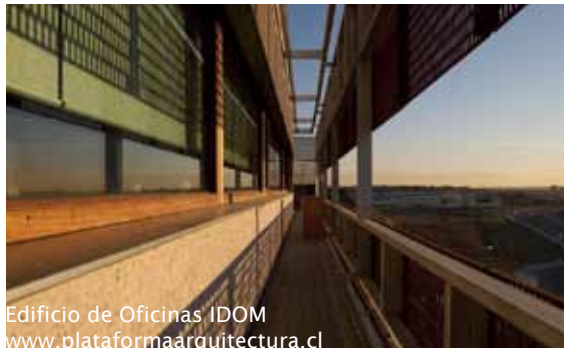
Edificio de Oficinas IDOM www.plataformaarquitectura.cl
