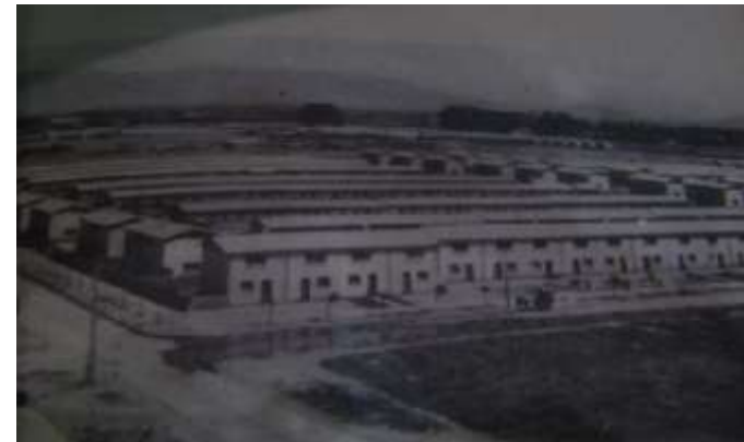
Vista general de los inicios de la población Miguel Dávila Carson (30)
