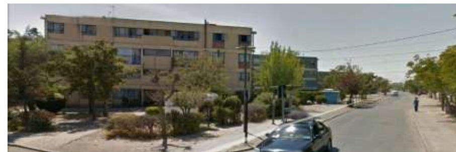
Bloque 4 pisos_ Calle Petrohue con Club Hípico
