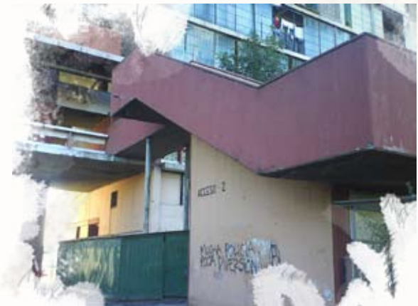
Escalera externa al bloque.
