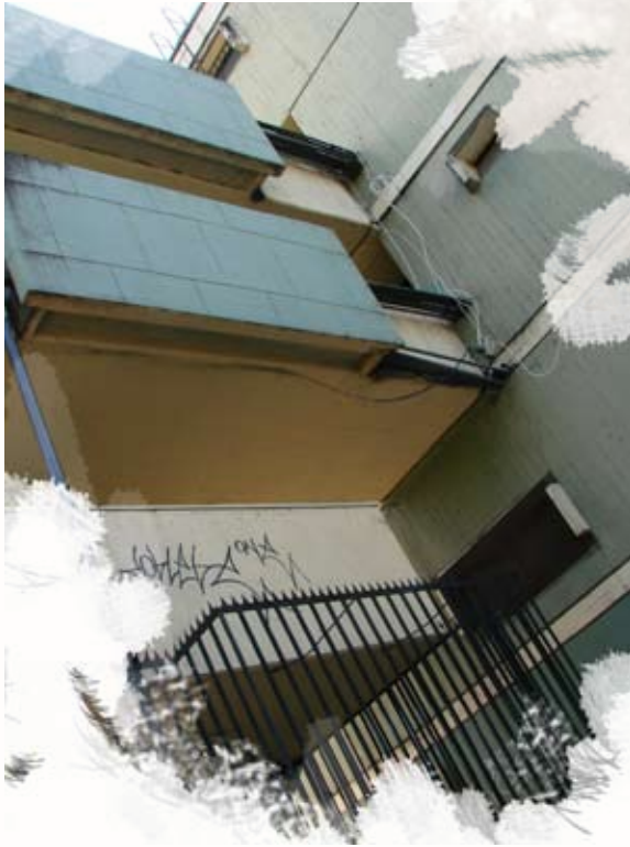
Bloque de departamentos de 3 niveles.
