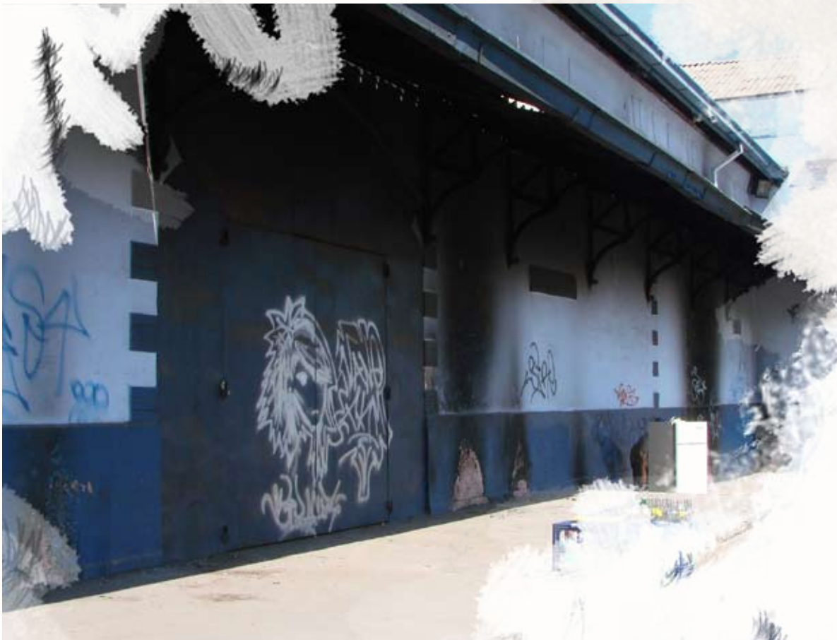
Sector Matadero en la actualidad.
