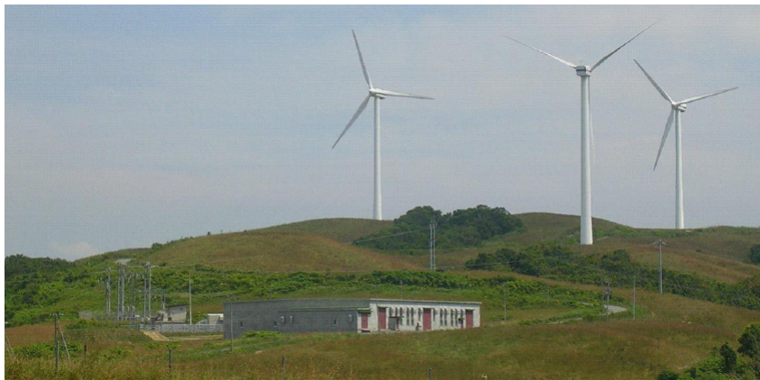
Figura 3.8: BESS de VRB de 4 MW en Tomamae, Japón.
