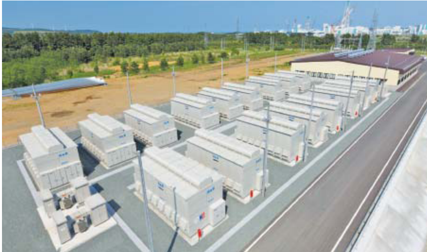
Figura 3.7: BESS de 34 MW(animación) de NaS en Rokkasho, Japón.
