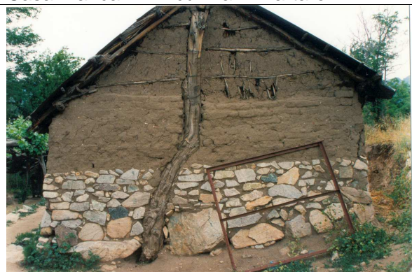
Fotografía 42. Estructura habitacional de Putaendo. Muestra técnica de enquinchado en su parte superior y base de piedra.
