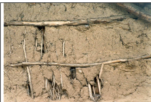
Fotografía 43. Detalle de técnica de enquinchado.
