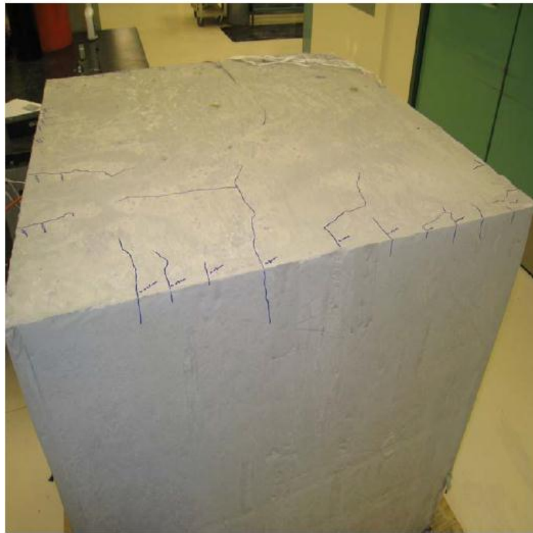
Figura 7-4: Cara superior del bloque experimental que muestra numerosas grietas a lo largo de los bordes (Lawrence 2009).
