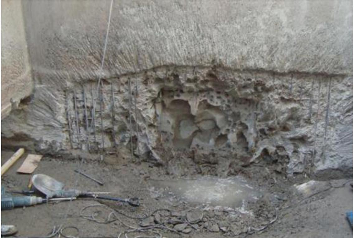
**Figura 2.13. Zona desgastada del cajón real.**
