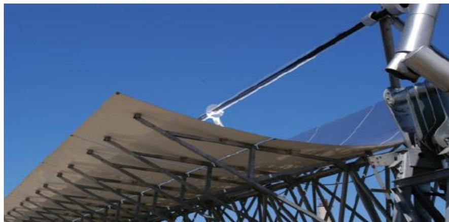
Figura 29: “Reflector Cilindro-Parabólico” [20]
