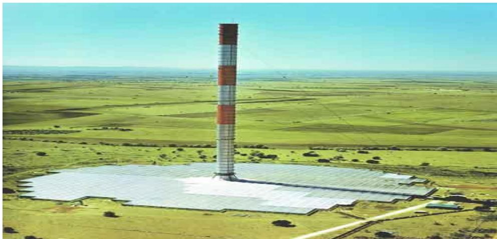
Figura 25: “Chimenea Solar, Manzanares (España)” [23]
