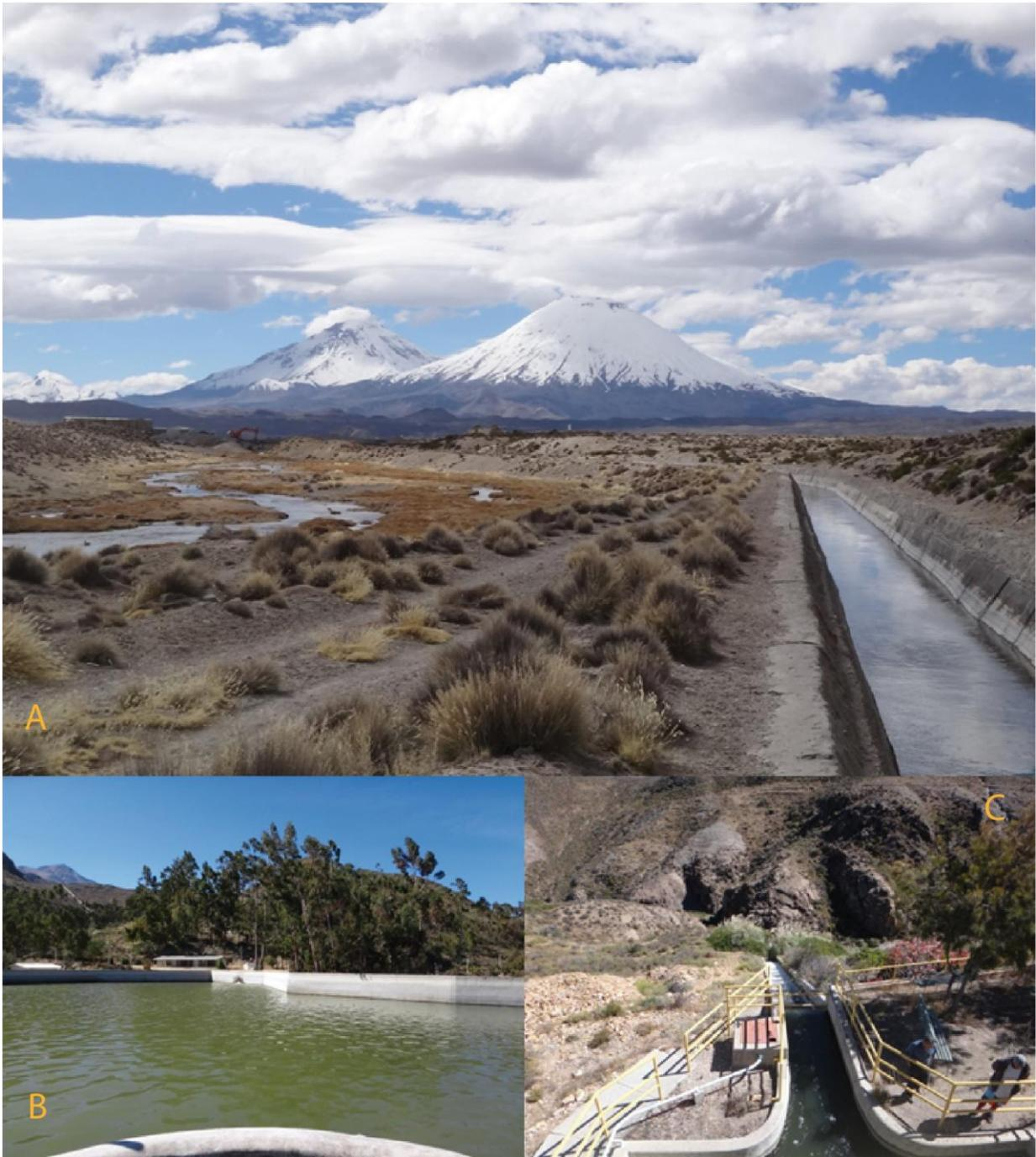
Figura 2. a) Río Lauca y Canal Lauca a los pies del volcán Paríncota, b) piscinas de acumulación de la Central Hidroeléctrica Chapiquiña, c) descarga del canal Lauca a alfuente del Río Tignamar.
