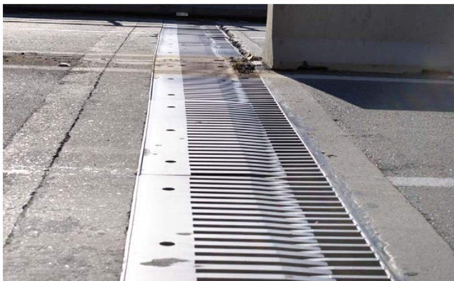
Figura 1.3: Junta de dilatación entre estribo sur y tablero.
