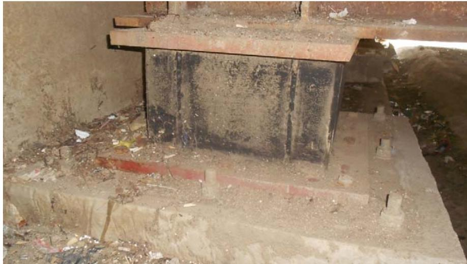
**Figura 1.10: Aislador elastomérico en estribo sur.**
