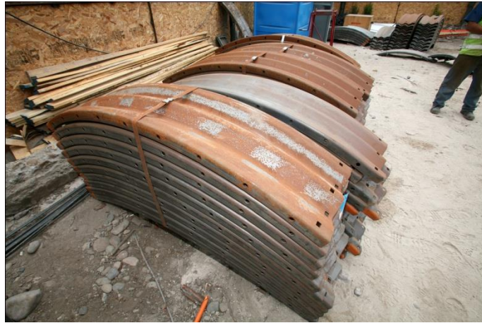
Ilustración 16: Acopio de planchas de tunnel liner.
