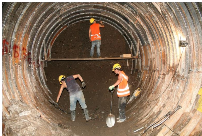
Ilustración 17: Frente de excavación de un tunnel liner.
