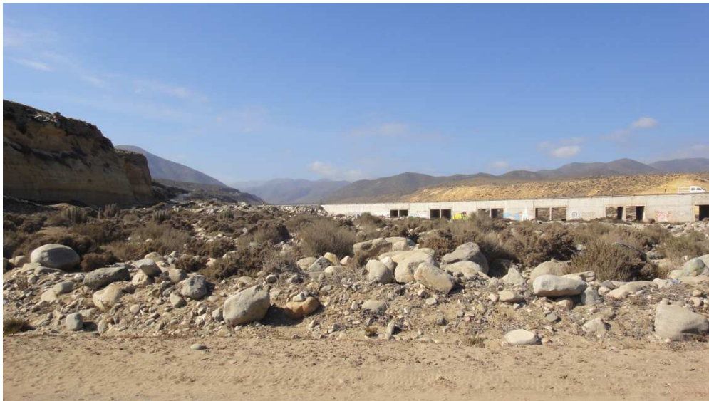
Figura 29: Puente de panamericana norte cruzando quebrada de Hornos (fotografía: campaña de terreno, Julio 2012, proyecto FONDECYT 1120234).
