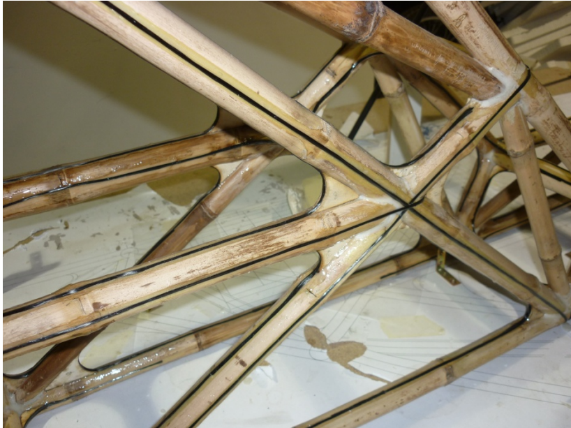
Ilustración 109 detalle de amarre de carbono.
