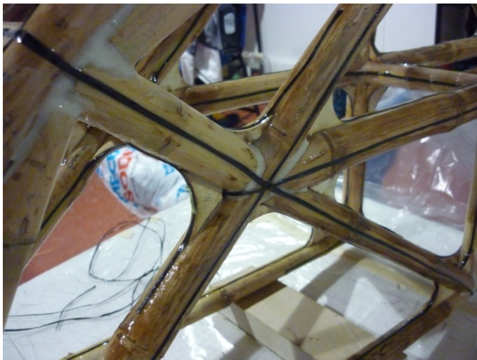
Ilustración 106 amarre estructural CFRP.
