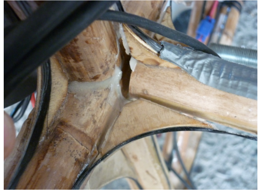
Ilustración 127 Detalle de integridad del amarre de fibra de carbón.
