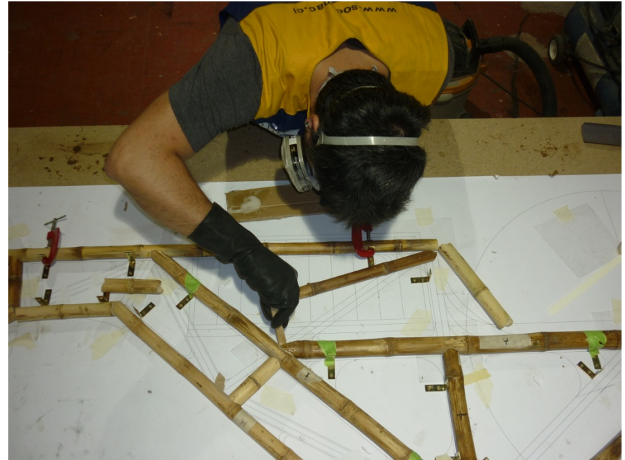
Ilustración 99 Armado de cara lateral del chasis.
