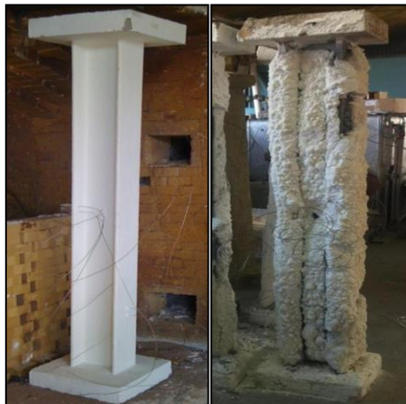
Figura 3-6: Perfiles de acero protegidos con PI antes (Izq) y después del ensayo (Der).
