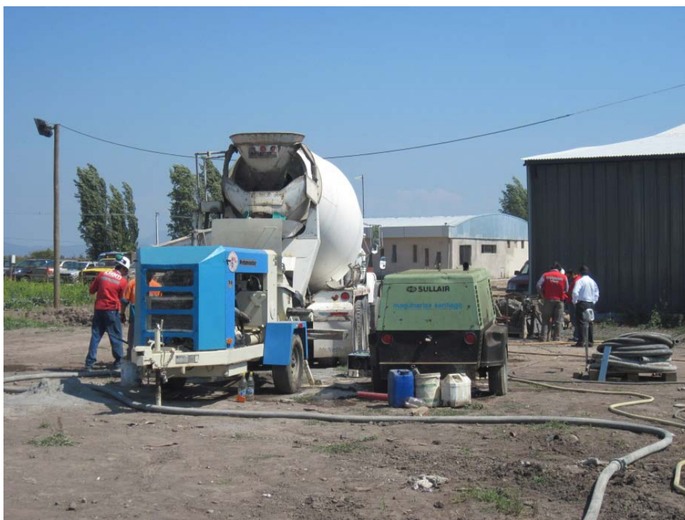
Figura 5.9. Equipos en terreno.
