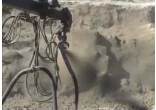
Figura 1.3. Proyección robotizada.
