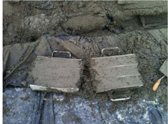
Figura 4.8. Moldes hormigón proyectado.
