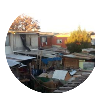
LGUC: Define esta situación como "Deterioro"
