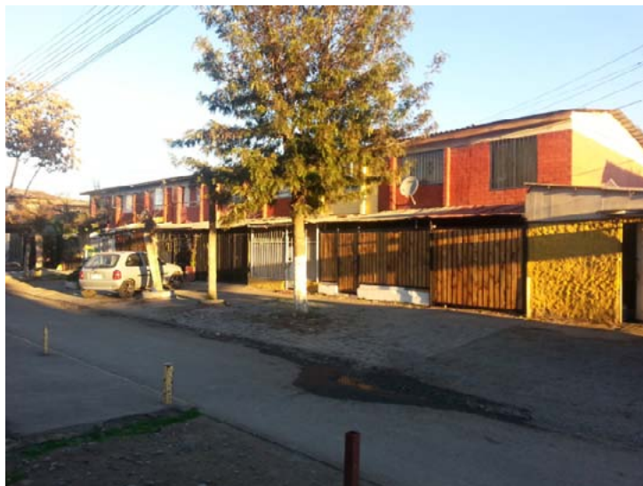
Fig.8: Fachada norte de la manzana a analizar. Fuente: Sebastián Román, 2013
