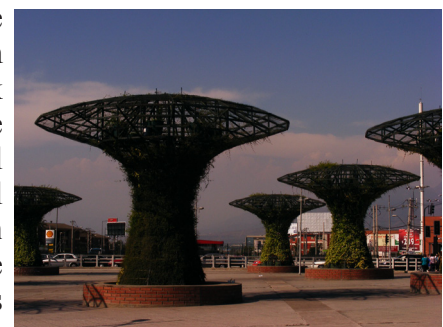
Fig.22 Estructuras de hierro en “Paradero 14” La Florida. Fuente: flickr.com/photos/lugar_citadino
