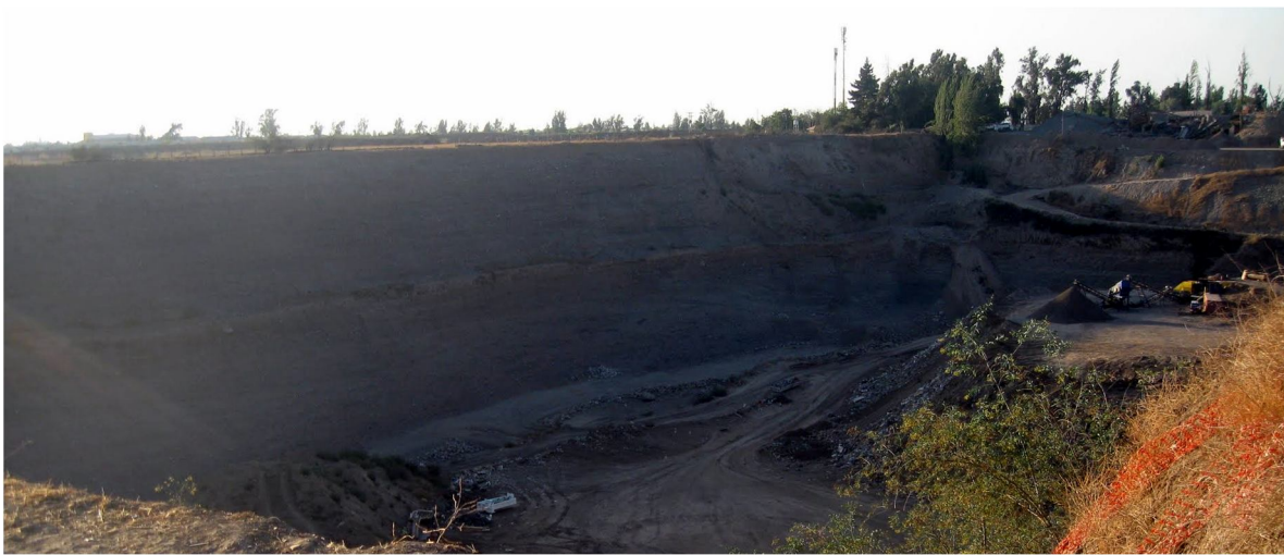
Figura 6.38: Fotografía del talud de la cantera.
