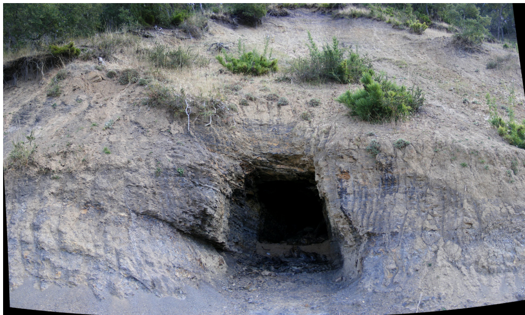
Figura L24-2. Túnel construido para faena minera abandonada.
