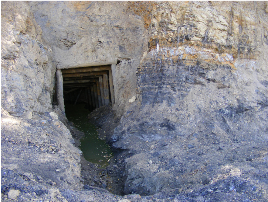
Figura L24-1. Túnel construido para faena minera abandonada.
