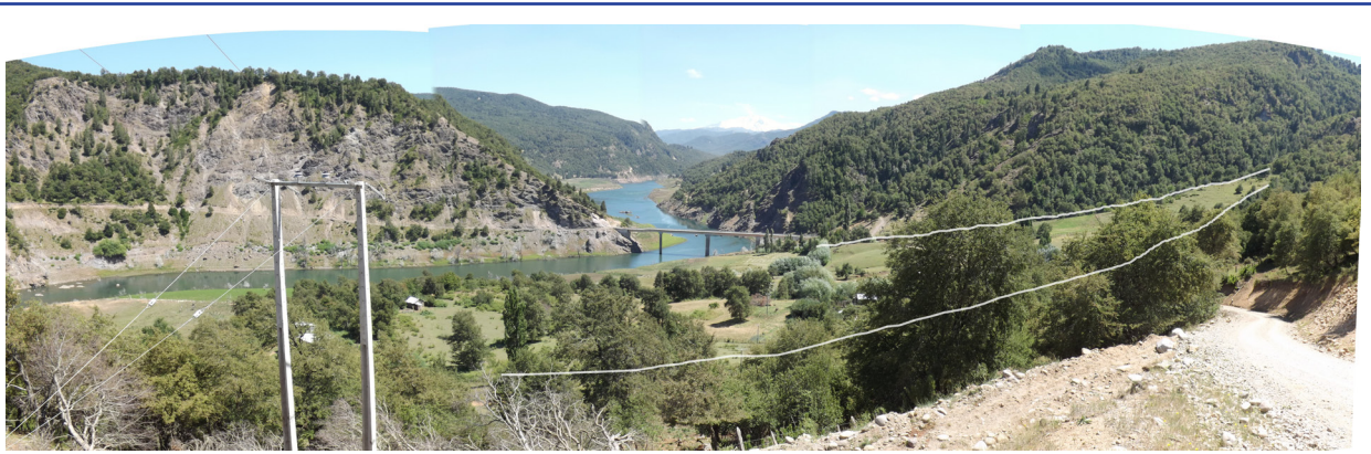
Fig.L07-8. Imagen tomada hacia el norte. Nótese el abanico que descende desde la quebrada al NE.
