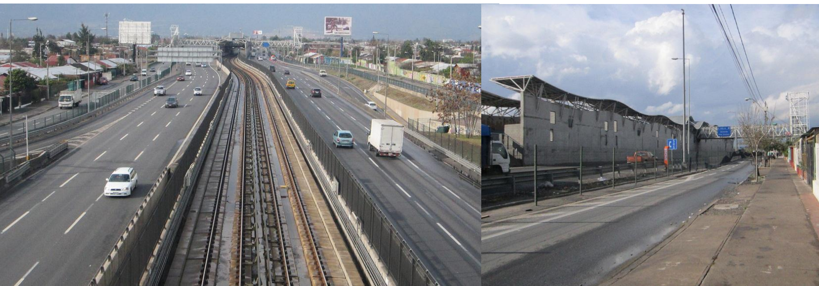
IMAGEN 6: Autopista Acceso Sur Santiago y Metro La Granja
