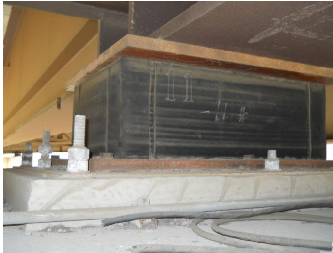
Figura 2-2. Aislador elastomérico de la cepa C4.
