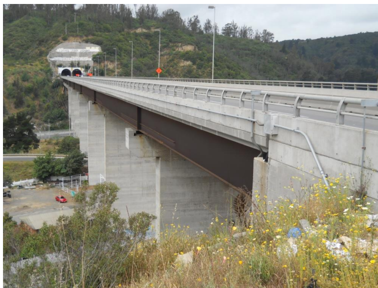
Figura 1-1. Puente Marga Marga visto desde el estribo sur.
