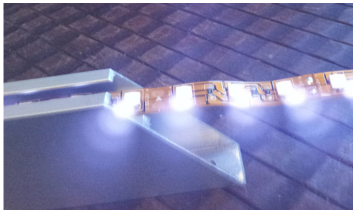
Infra-rojos encendidos, celulares de mala calidad pueden captar de mejor forma el haz de luz.
