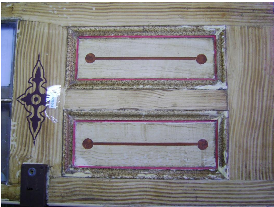
Imagen 73 y 74: proceso de reintegración en puerta 32 en etapas 1 y 2
