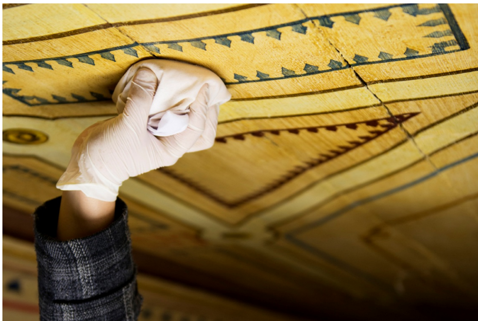
Imagen 106 y 107: pulido de cera micro cristalina y aplicación de capa final mate
