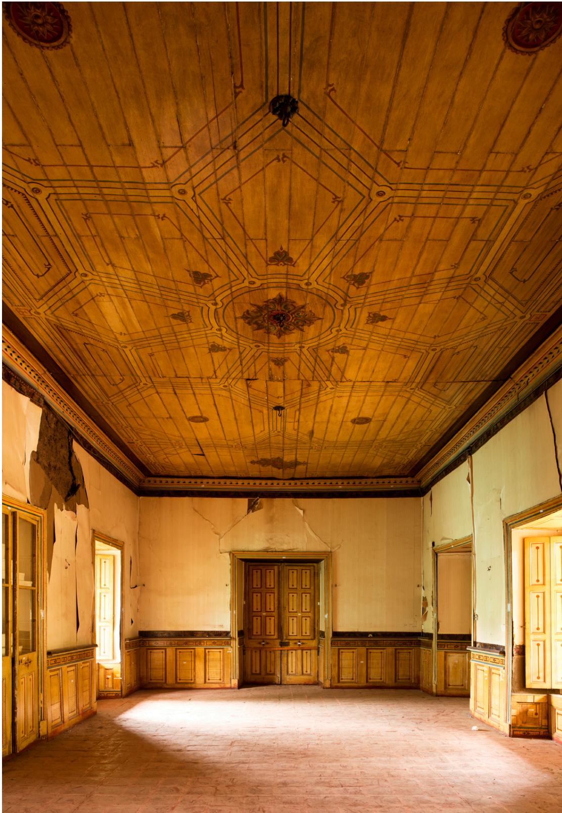
Imagen 110: registro fotográfico previo a los trabajos de restauración
