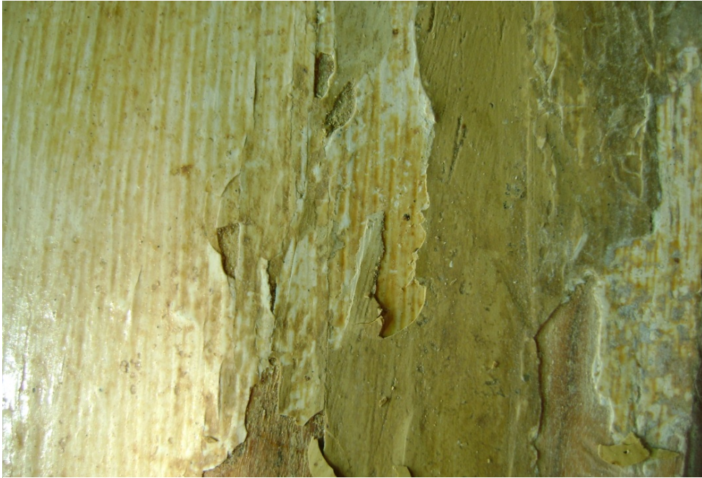
Imagen 35: detalle masilla en unión de tablas cielo
