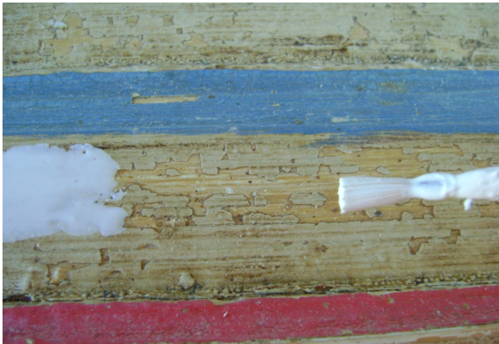
Imagen 70: aplicación de estuco en pérdida de capa pictórica
