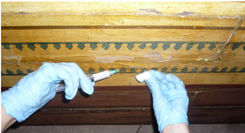
Imagen 88: inyección de mowilith para consolidar los levantamientos de capa pictórica
