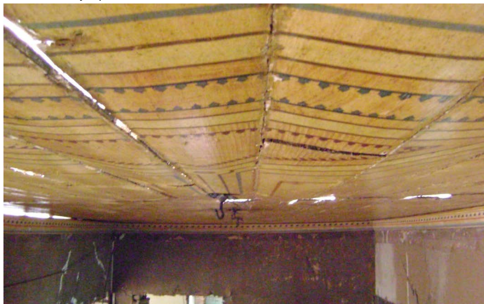
Imagen 32: apertura entre tablas cielo
