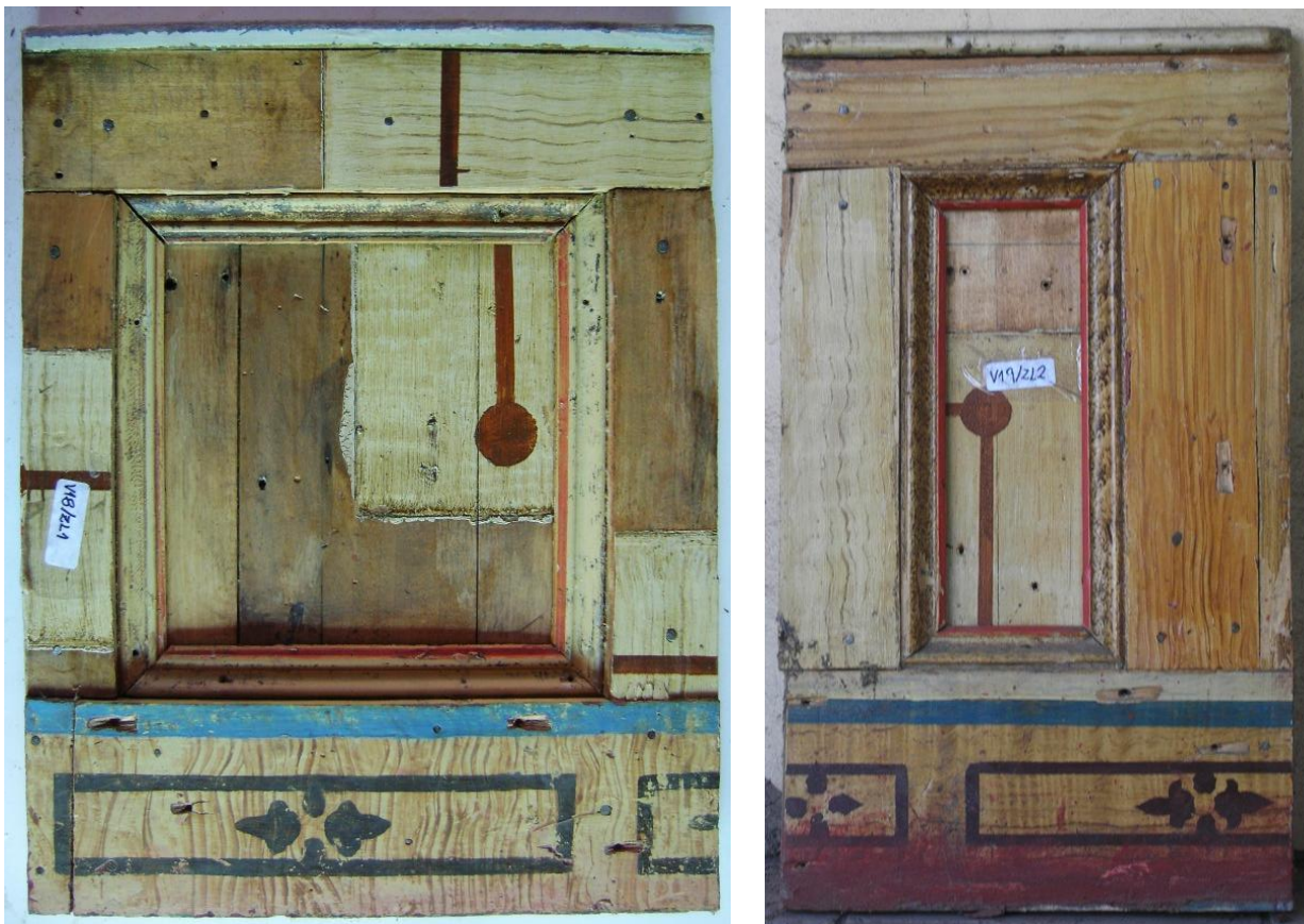
Imagen 12 y 13: Detalle 2 piezas intervenidas luego de la inundación
