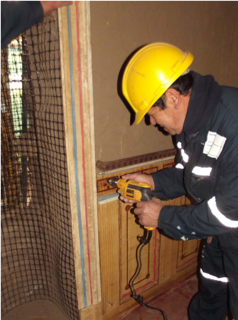
Imagen 81: carpintero instalando zócalos
