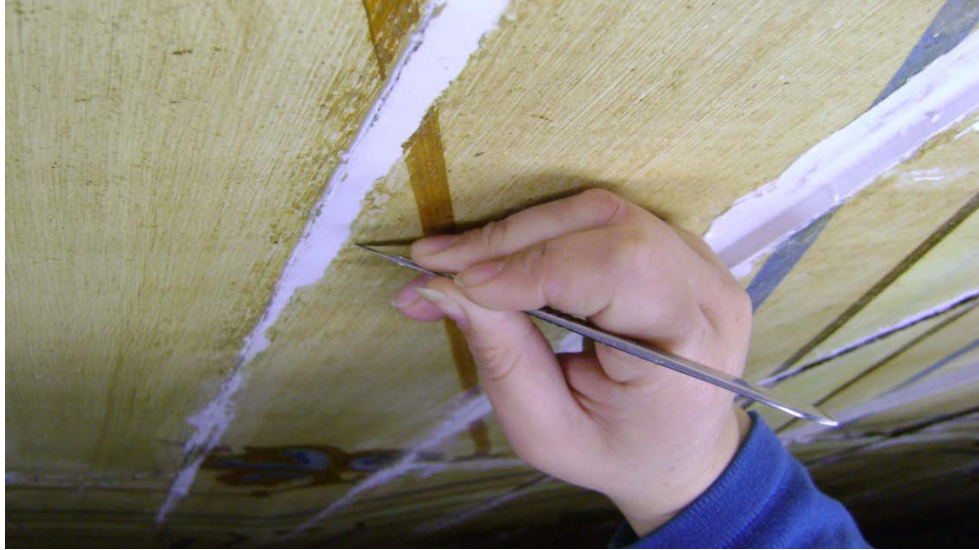
Imagen 100: pulido de yeso con bisturí
