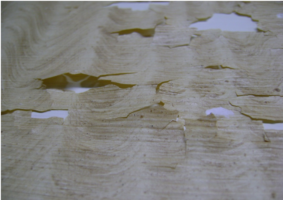
Imagen 27: Detalle levantamiento capa pictórica en puerta vitrina NM5
