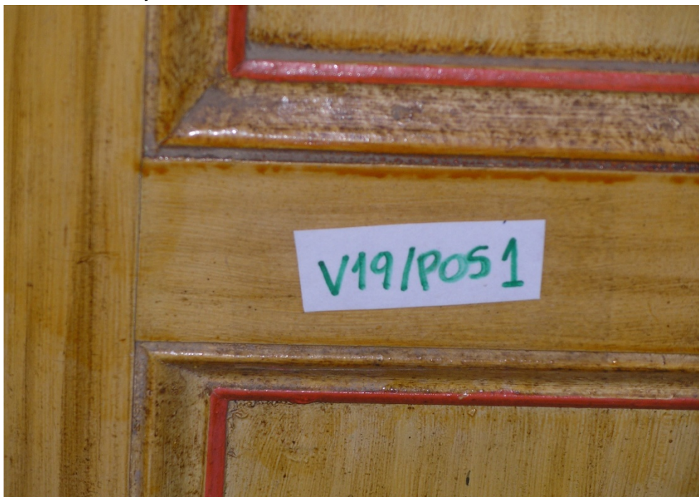
Imagen 30: Detalle excesos de barniz en postigo ventana 19
