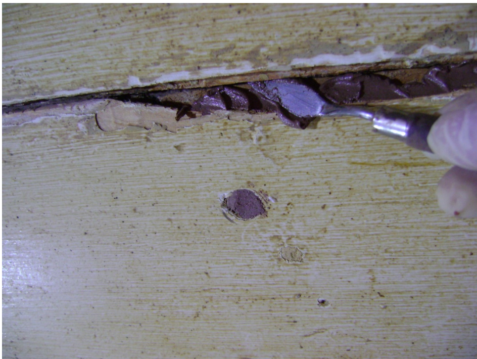
Imagen 47 y 48: proceso de pegado de astillas y aplicación de araldite madera
