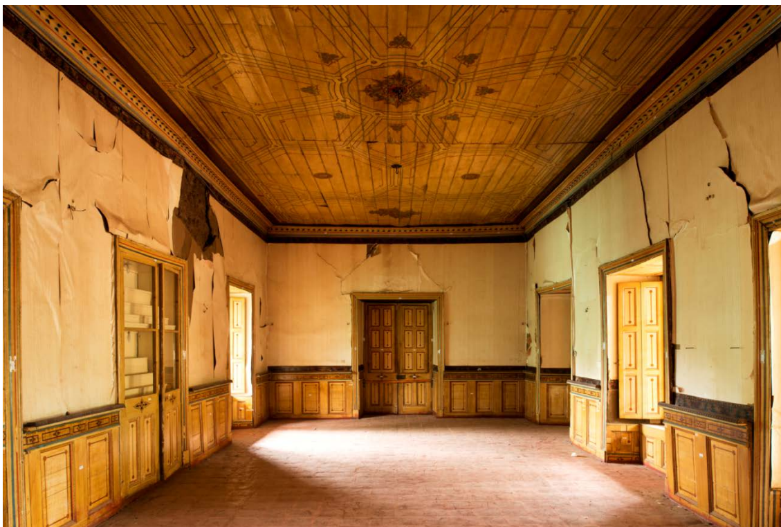
Imagen 6: Registro fotográfico comedor previo al desarme.
