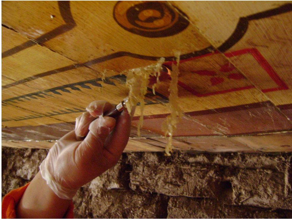
Imagen 90: detalle eliminación con espátula de barniz reblandecido por diluyente acrílico
