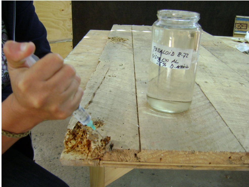
Imagen 58: consolidación de madera debilitada por ataque de xilófagos con inyección de paralord B-72
