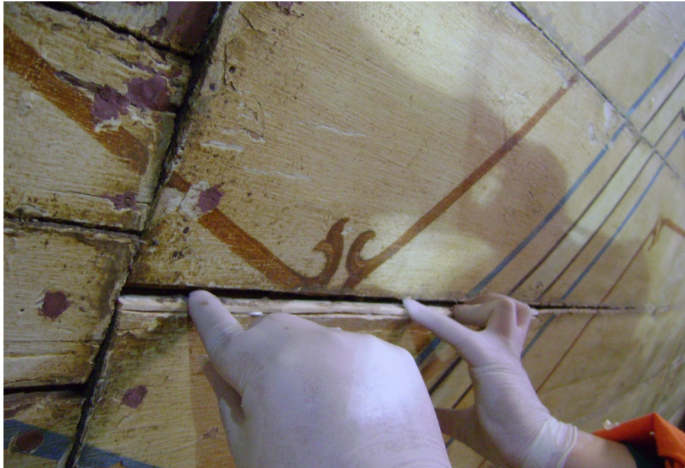
Imagen 96: detalle injerto en madera de álamo
