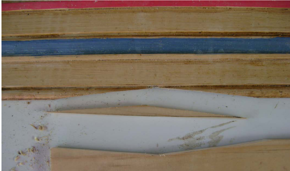
Imagen 67: detalle injerto en pilastra con madera de álamo
