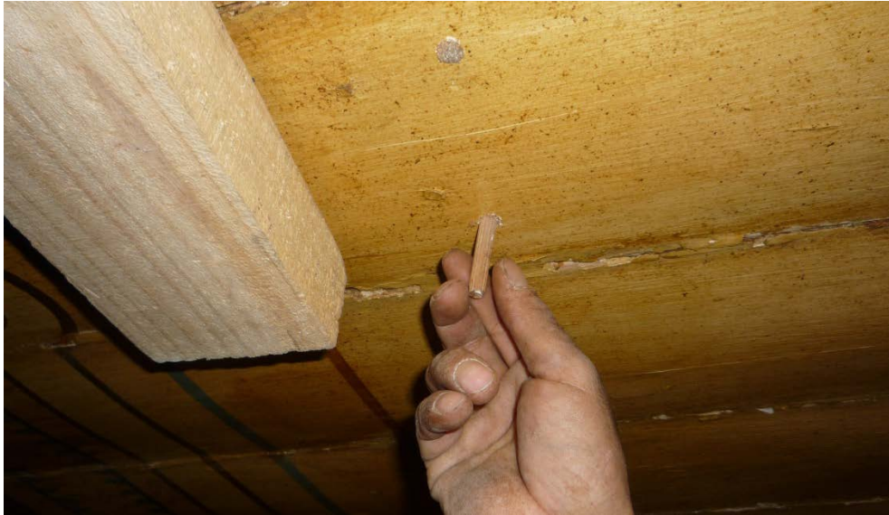
Imagen 87: utilización de tarugos para fijar tablas de cielo contra vigas superiores
