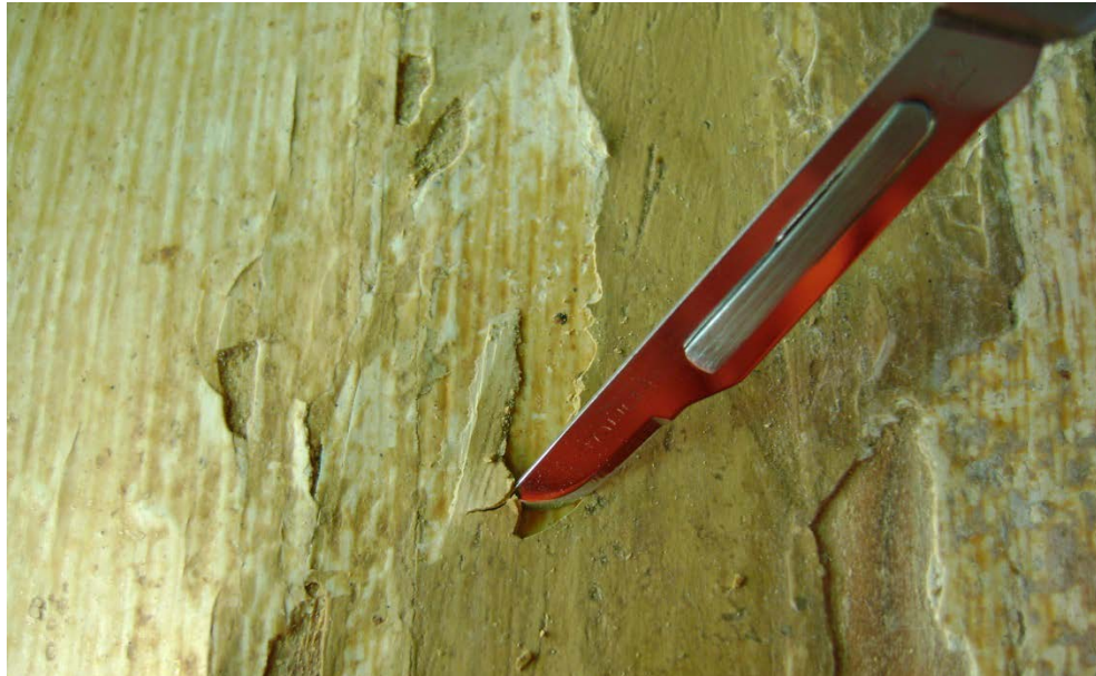
Imagen 94: detalle eliminación de masilla con bisturí
