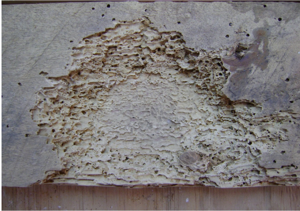
Imagen 22: Detalle ataque xilófagos reverso cubre antepecho ventana 17
