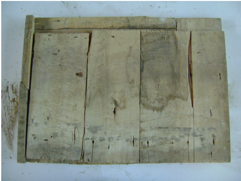
Imagen 21: Detalle reverso zócalo lateral ventana 18
