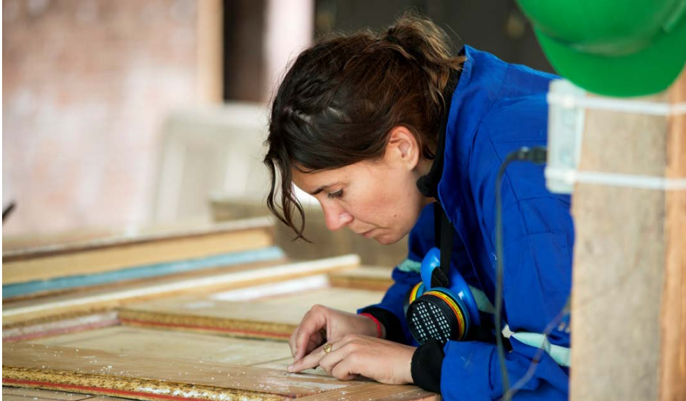
Imagen 51: proceso de pulido de yeso
