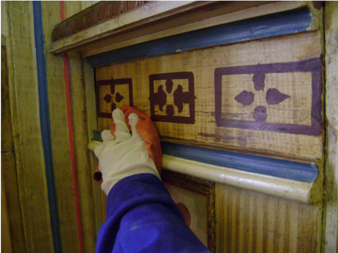
Imagen 83: aplicación de cera en los zócalos en etapa de pulido
