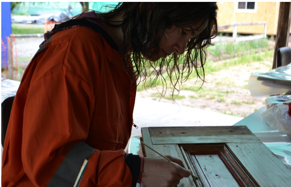
Imagen 45: proceso de eliminación de barniz
