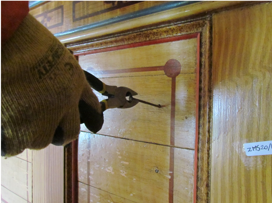
Imagen 46: proceso de extracción de clavos
