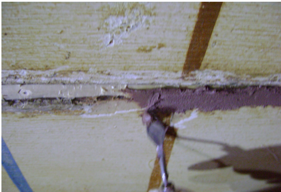
Imagen 97: aplicación de araldite madera en grietas y unión con injerto
