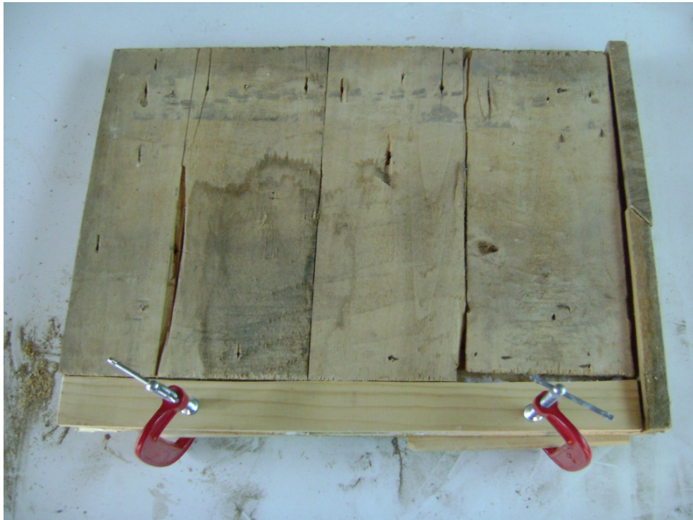
Imagen 57: instalación de pieza de madera adicional para reforzar estructura de zócalo lateral ventana 18
