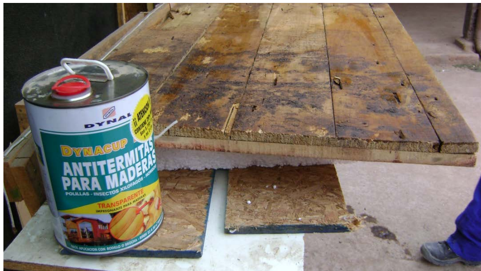
Imagen 61: aplicación de químico fungicida preventivo de ataques posteriores
