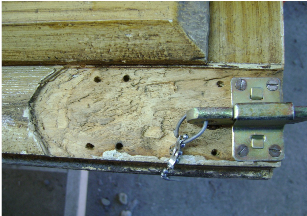
Imagen 25: Detalle modificaciones quincallería en puerta PV30
