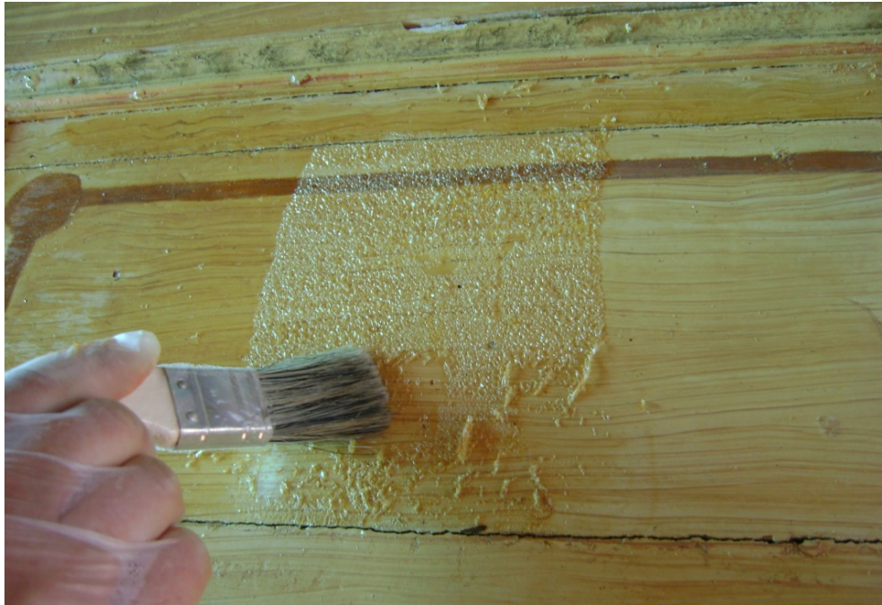
Imagen 63: detalle eliminación de barniz con brocha una vez actuado el diluyente acrílico aplicado
