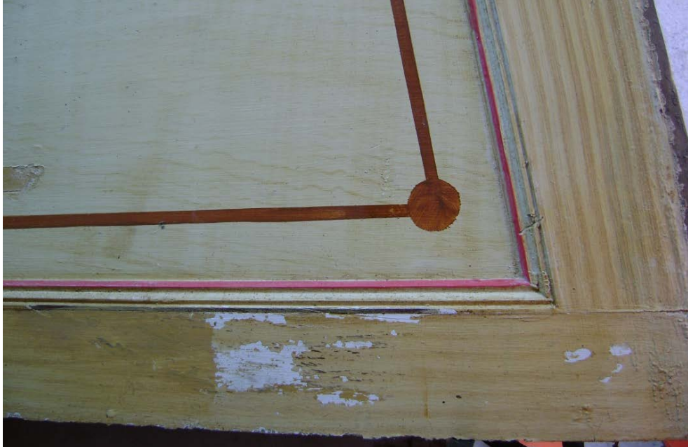
Imagen 65: cubre dintel con proceso de eliminación de repintes a la mitad
