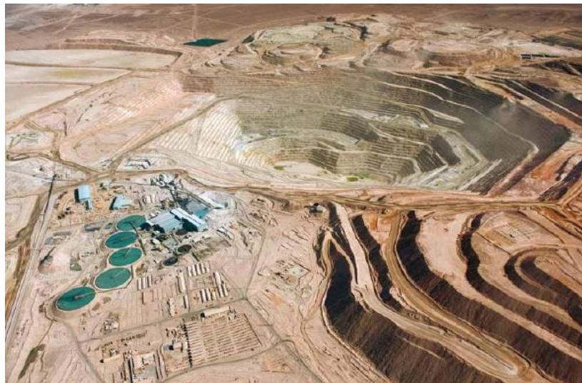
ILUSTRACIÓN 15: VISTA MINA RAJO ESCONDIDA.
