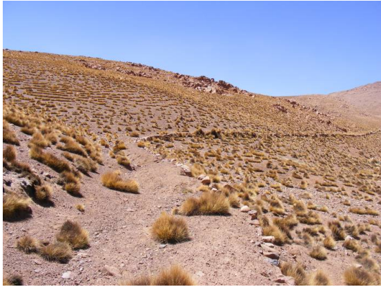
Fig. 40 Segmento QB1 con muro de contención. Sector Quebrada Blanca vista noreste.
