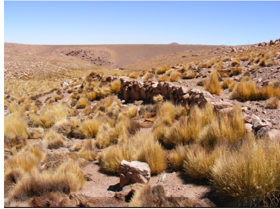
Fig. 41 Detalle del muro de contención segmento QB1.
