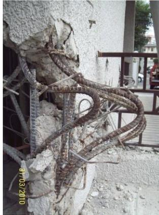
*Figura N° 1.2 - Pandeo del refuerzo longitudinal en elementos de borde durante el terremoto del 27-F*
