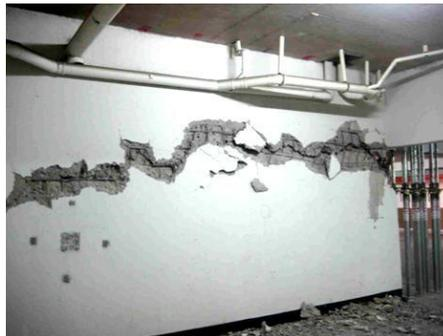
*Figura N° 1.1 - Grieta Horizontal en Muro Subterráneo durante el terremoto del 27-F*
