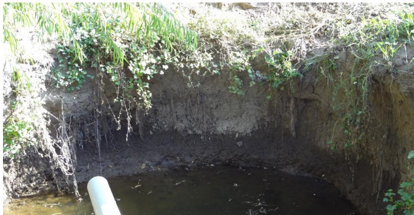
Figura 39: Noria en construcción con nivel freático a 1,1 metros de profundidad. En la imagen se puede observar la estratigrafía del pozo, la cual según visto en terreno correspondía a arenas, limos y arcillas, confirmado posteriormente por los análisis granulométricos. Coordenadas geográficas: 6215825N/325511E. Muestras AV339-341
