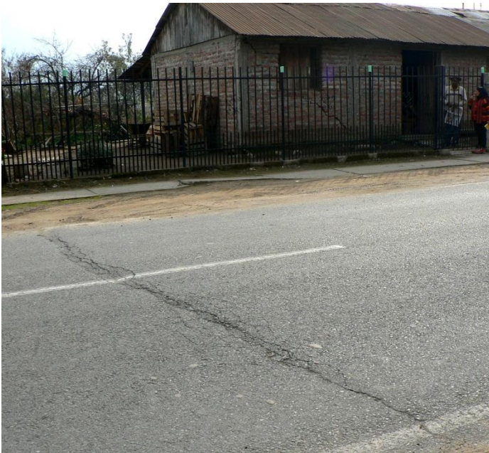
Anexo H 4: Punto 37. Grieta en el camino y daños estructurales en vivienda.
