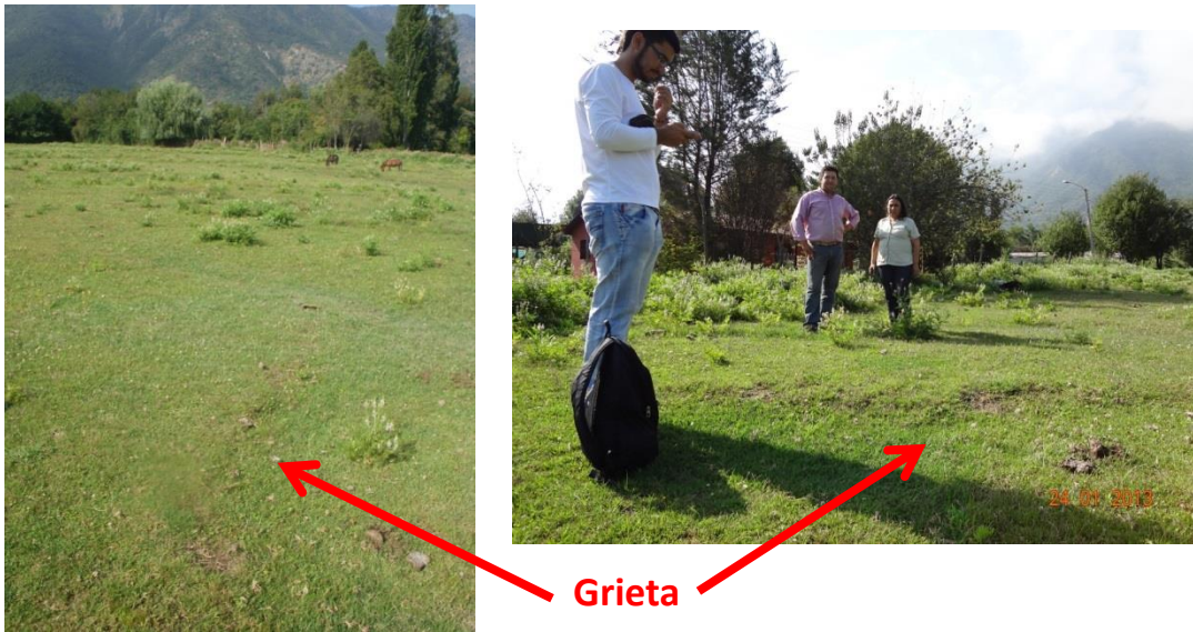
Anexo H 11: Punto 65. Grietas con orientación N40E.
