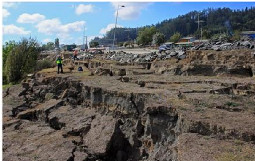
Figura 11: Falla de terreno producto de la licuefacción en un depósito de relleno al norte del Puente La Mochita, Concepción, Chile, durante el terremoto del 27 de Febrero de 2010.
