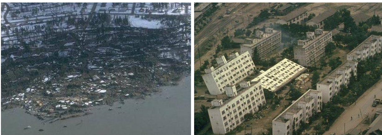
Figura 10: A la izquierda: Licuefacción de flujo en The Turnagain Heights, Alaska, durante el terremoto de 1964 el cual se piensa fue gatillado por la licuación de lentes de arenas en un área deslizada de 130 acres. A la derecha: Pérdida de la capacidad soporte del complejo de departamentos en Kawagishi-cho durante el terremoto de Niigata de 1964.
