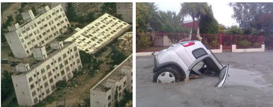
Figura 15: A la izquierda: daños generados por el fenómeno de licuefacción durante el terremoto de 1964 en Niigata, Japón. A la derecha: Automóvil enterrado debido a la pérdida de resistencia del suelo durante el terremoto de 2011 en Christchurch, Nueva Zelanda.
