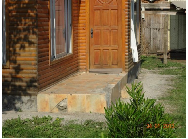
Anexo H 9: Punto 63. Casa de madera construida sobre una losa/radier de cemento arena y ripio. No sufrió daños estructurales.
