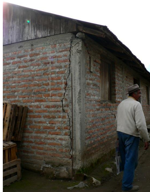
Anexo H 4: Punto 37. Grieta en el camino y daños estructurales en vivienda.
