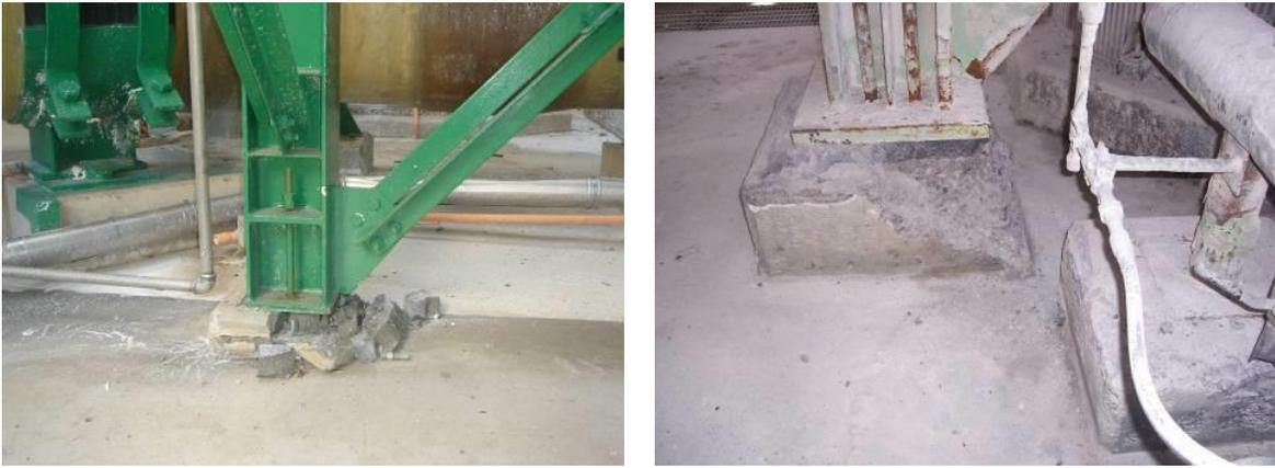
Figura 2.16: Pedestales fracturados por corte local (Montecinos et al., 2012)
