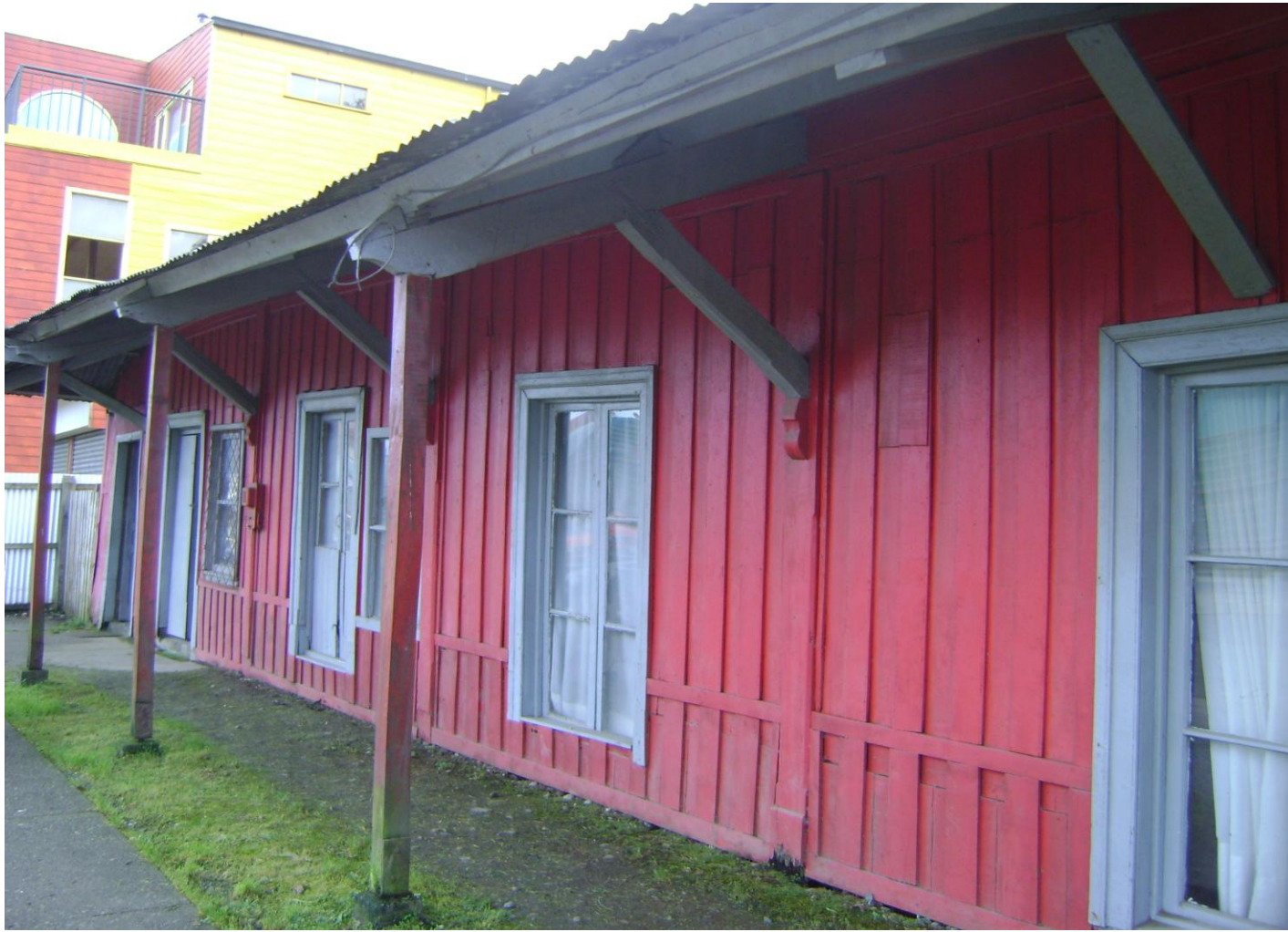
Imagen n° 26: “Edificio de la antigua estación del ferrocarril en Ancud.” Fotografía tomada por la autora en mayo de 2011.
