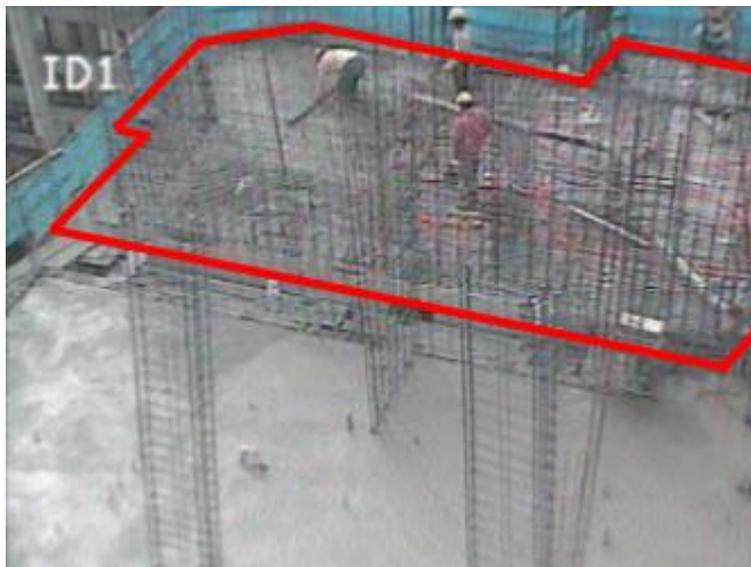
Figura 36: Identificación de área hormigonada en la medición del 10 de abril.
