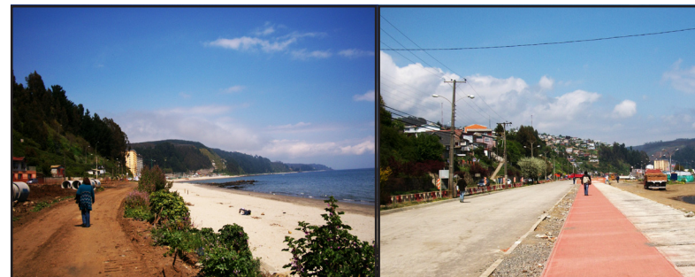
AVANCE ACTUAL DEL CORREDOR AV. LATORRE / Elaboración Propia
