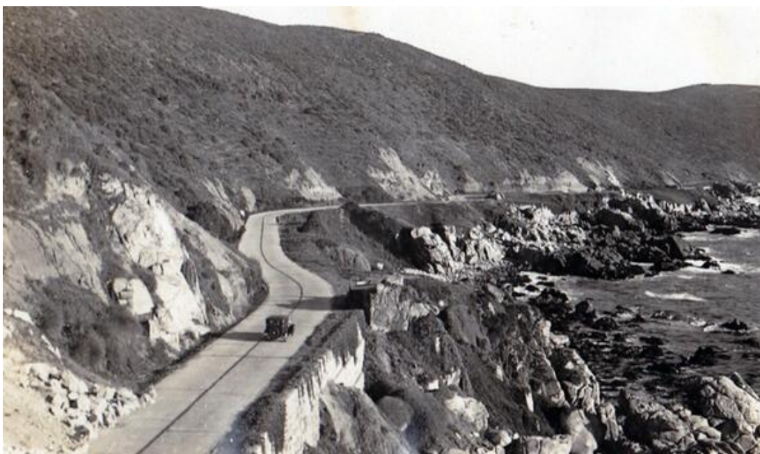
Pavimentación Camino Viña del Mar – Concón (finales años veinte)
