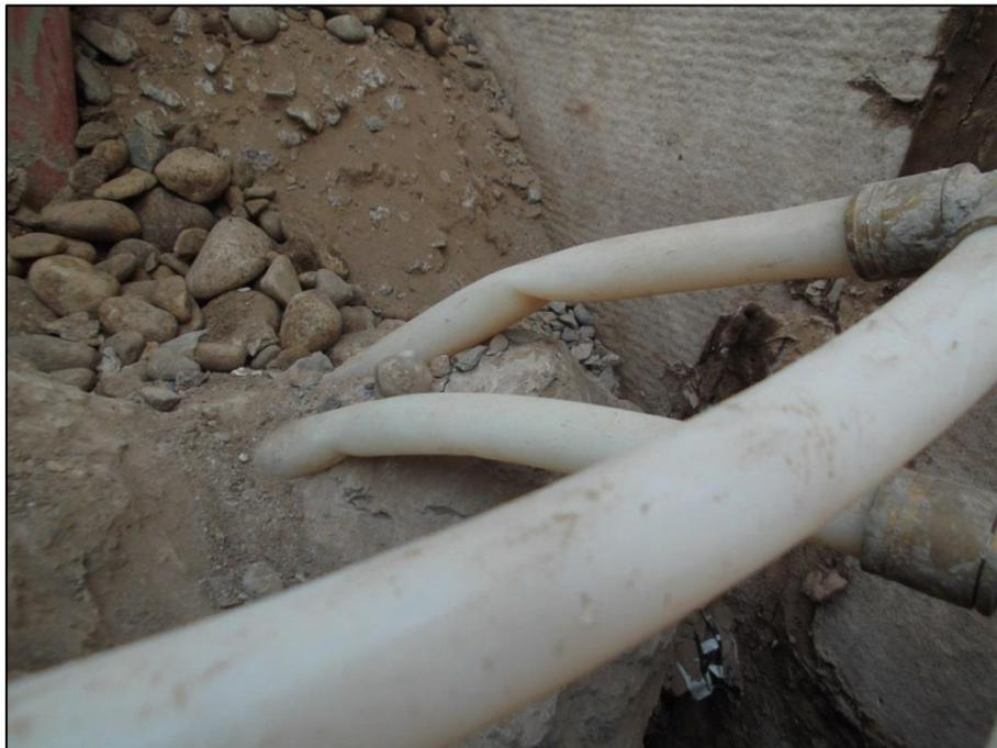
Anexo A.2: Tuberías del circuito de la Pila 101 dobladas (03-04-2013).
