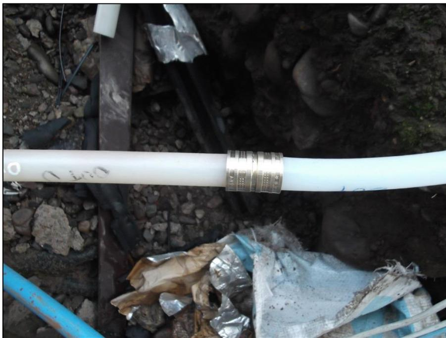
Anexo C.1: Conexión de tuberías nuevas mediante *fittings*, se aprecia la diferencia de colores entre tuberías.
