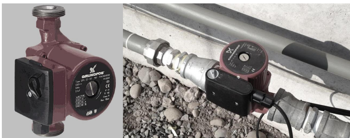
Figura 15: Bomba Grundfos 32-80 (izquierda) y bomba instalada en circuito de alimentación a intercambiador (derecha)
