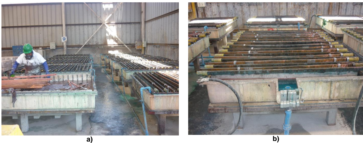
Figura 4.7: Planta de Electrorefinación: a) Tinas de lavado de barras, b) Disposición de barras para lavado.
