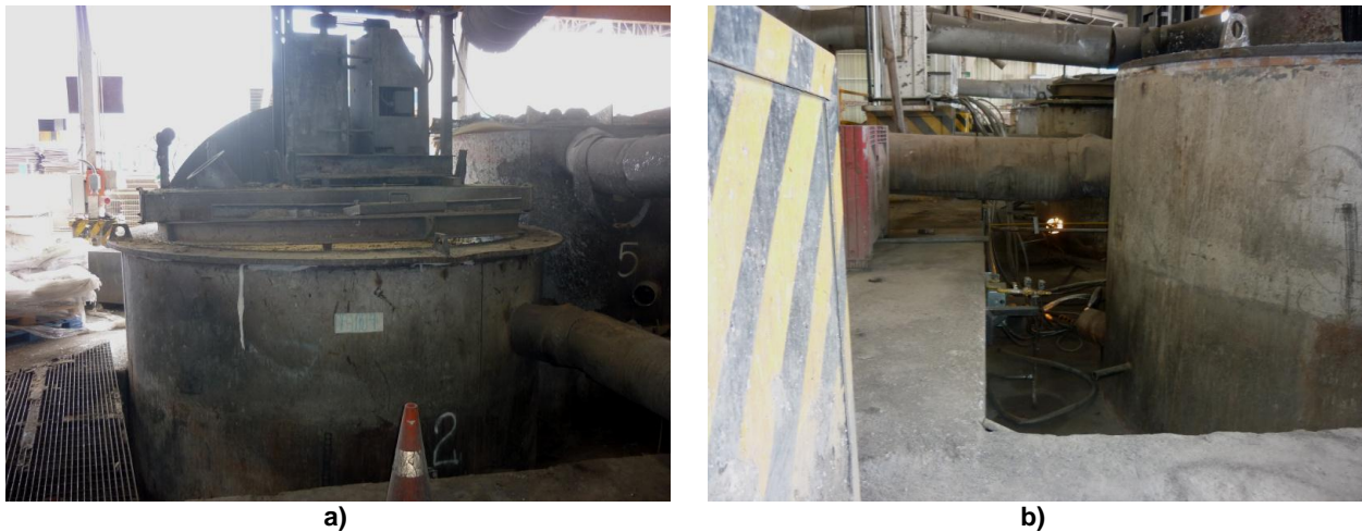
Figura 4.6: Proceso de fundición en Ollas de Refino: a) Olla de Refino con equipo de mezcla sobre su tapa, b) Vista lateral donde se observa un quemador expuesto.
