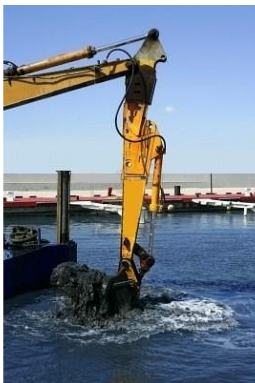
Figura N°17. Draga mecánica utilizada para extraer sedimentos desde el fondo marino.
