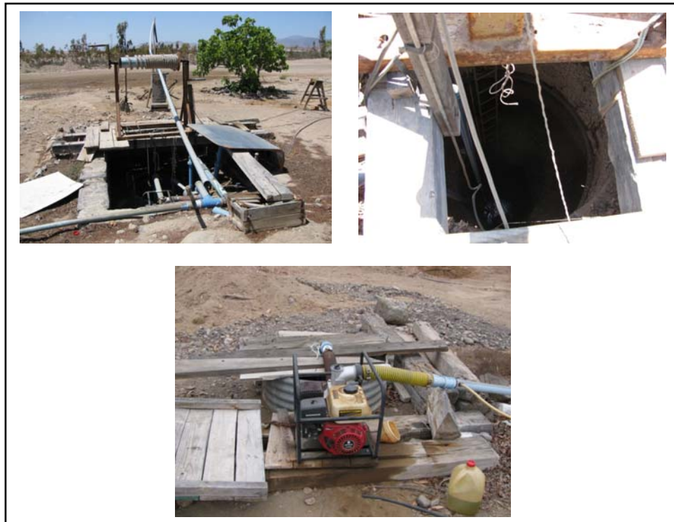
Figura 6. Pozos y bomba de extracción en predios de Canto del Agua (Fuente: elaboración propia)
