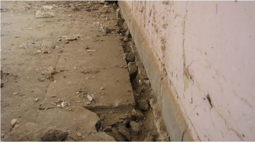
Fig. 4 Grieta muro-losa
