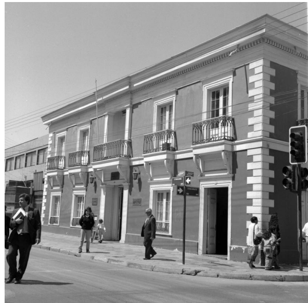
Figura 34 Casa esquina en Caldera 1990 Foto: Roberto Montandon
