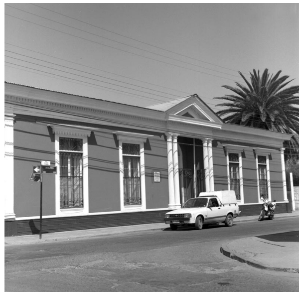
Figura 35 Casa en Caldera 1990 Foto: Roberto Montandon
