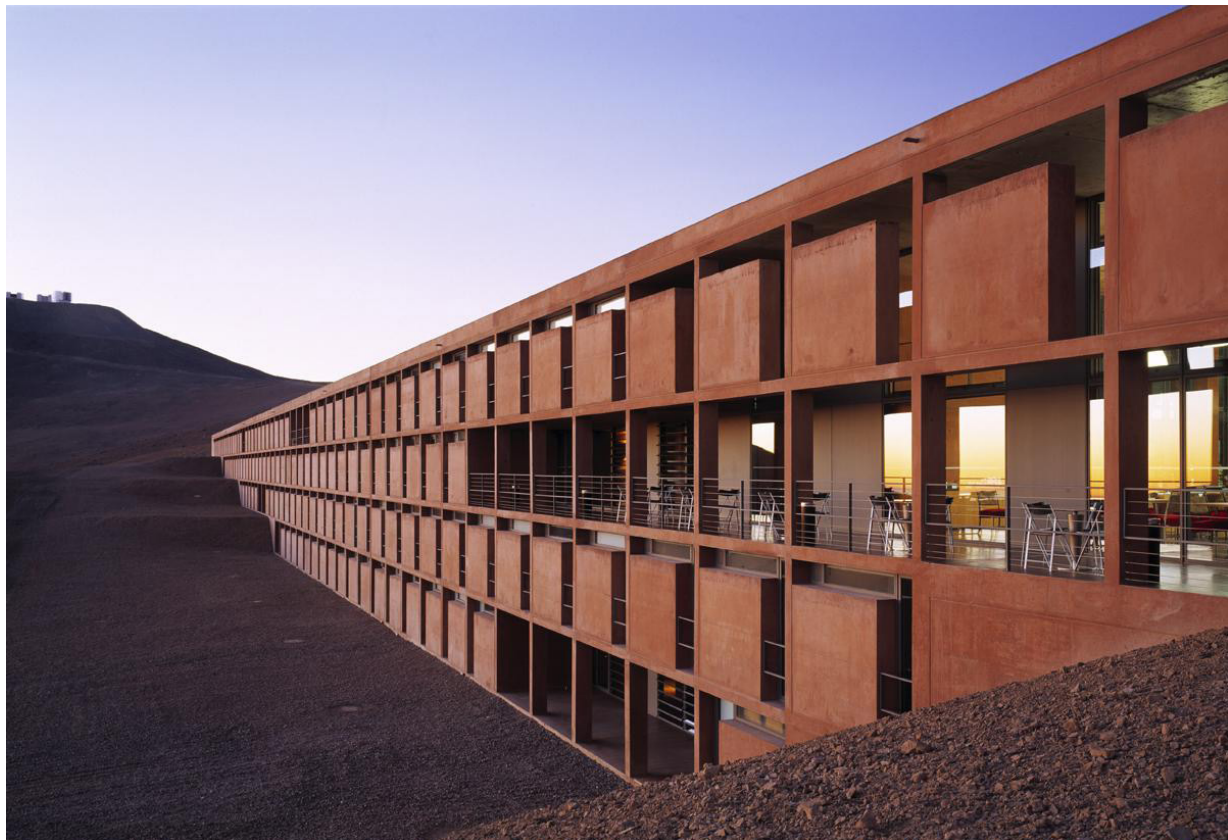
Figura 64 Fachada hotel ESO Fuente: Auer+Weber+Assoziierte
