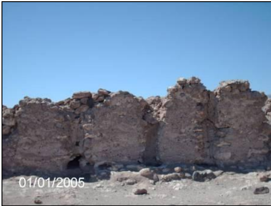
Figura 12. Vista de los negativos de postes en los muros.
