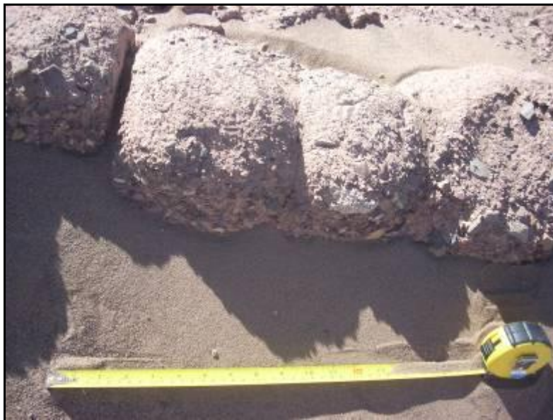
Figura 22. Adobones de los muros, (E.11).
