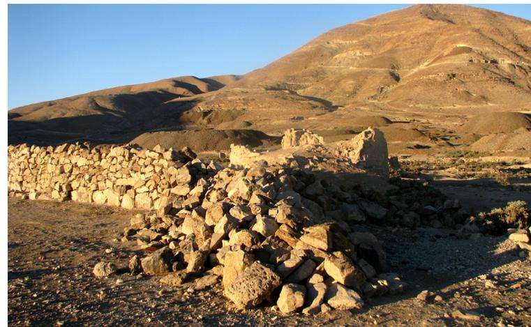
Figura 124: Ruinas de Juan Godoy en las que se aprecia el sistema constructivo preponderante en el lugar, los tapiales y la mampostería en piedra.
