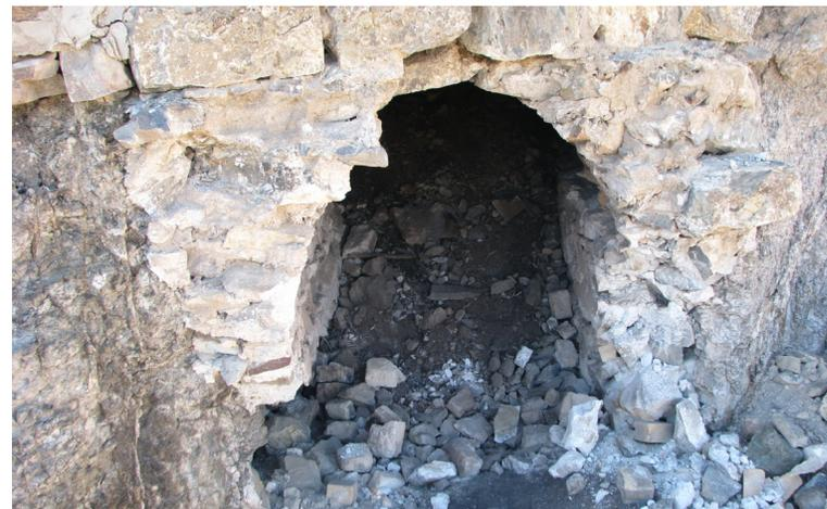
Figura 145: Horno de ladrillo y piedra en donde se realizaba la fundición del mineral.
