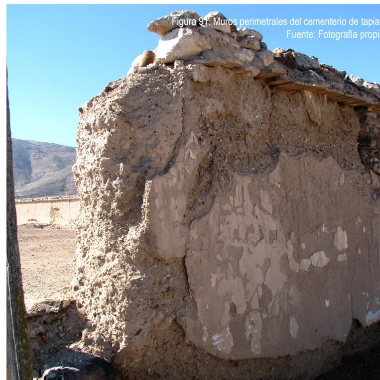
Figura 91. Muros perimetrales del cementerio de tapial.
