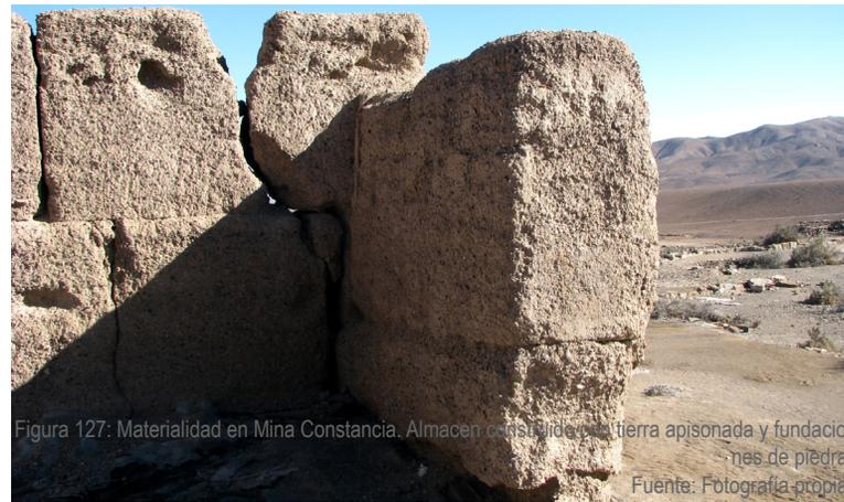
Figura 127: Materialidad en Mina Constanza. Almacén construido para tierra apisonada y fundaciones de piedra.
