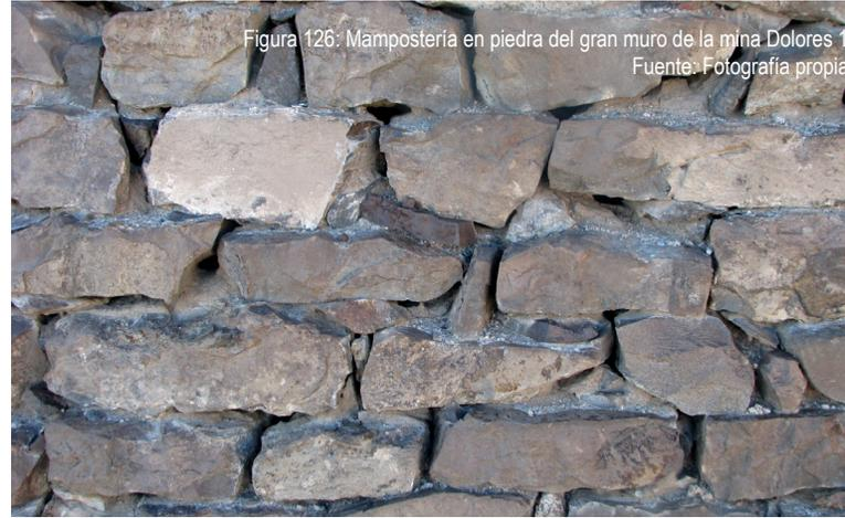
Figura 126: Mampostería en piedra del gran muro de la mina Dolores 1.
