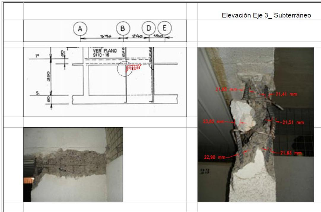
Figura 7: Muros con daño en eje 3, Bonelli (2010).
