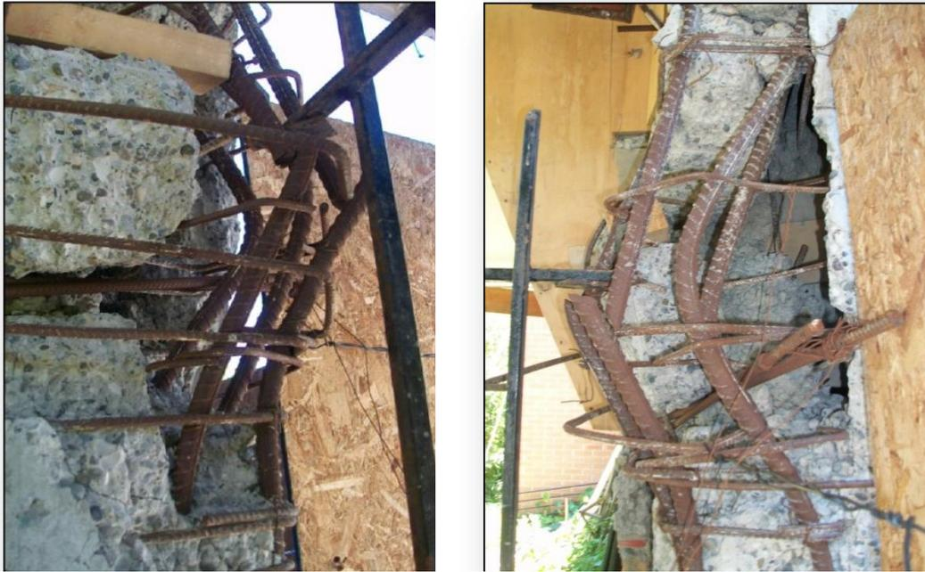
Figura 6: Barras de refuerzo con pandeo y fractura, Aguilar (2012).
