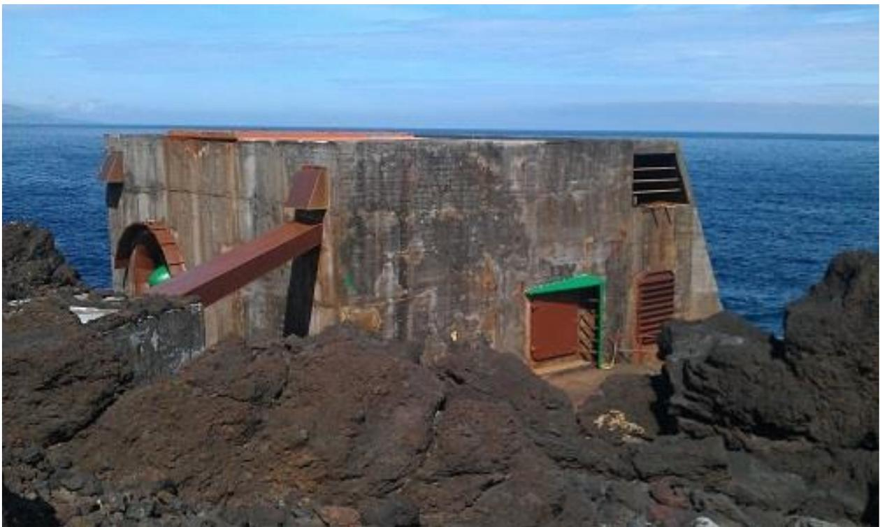
**ILUSTRACIÓN 11: PICO OWC INSTALADA Y FUNCIONANDO EN AMBIENTE MARINO.**
