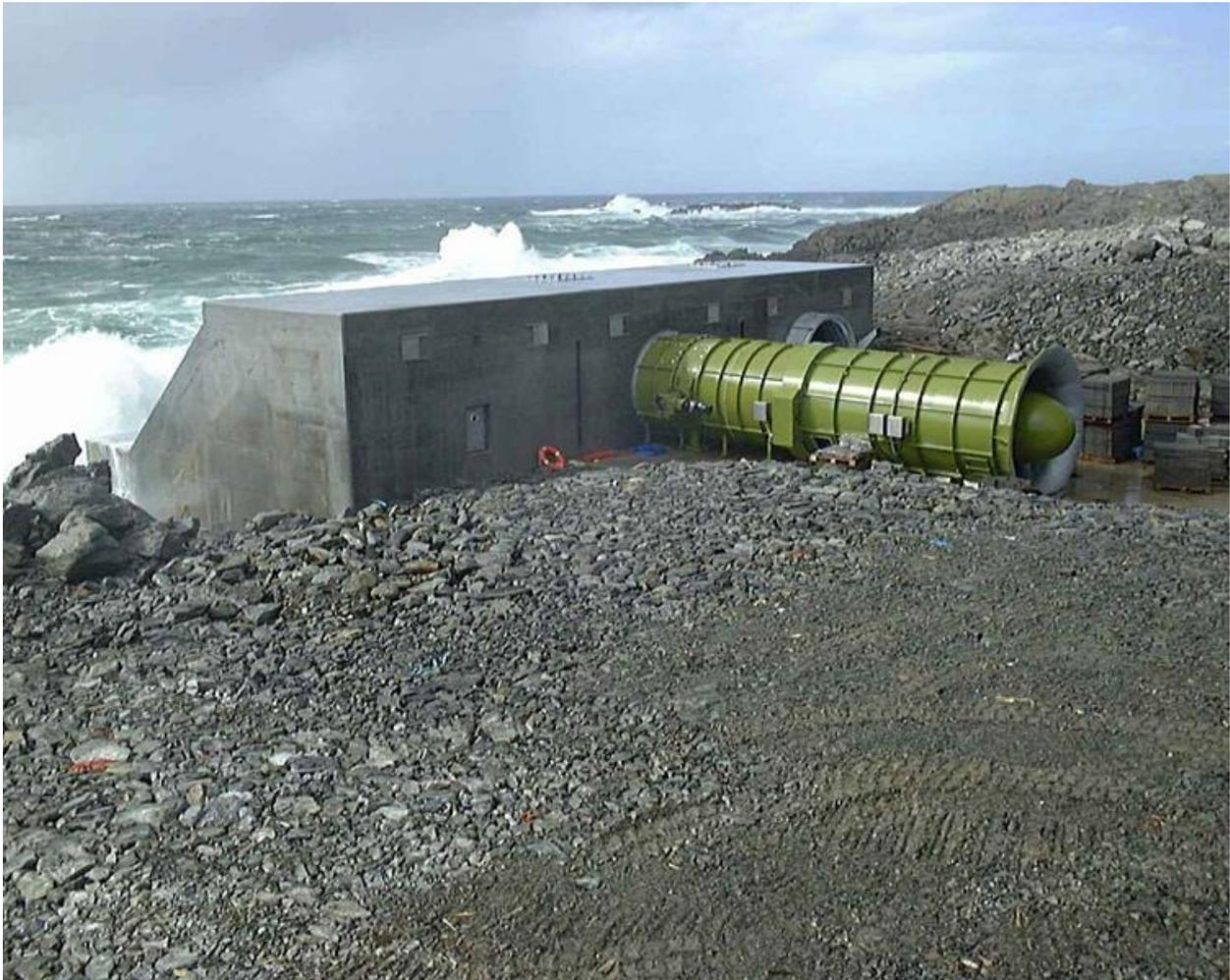
ILUSTRACIÓN 10: LIMPET INSTALADA Y FUNCIONANDO EN AMBIENTE MARINO.
