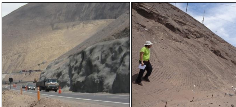
Ilustración 3.27 : Shotcrete y mallas como medidas de mitigación
