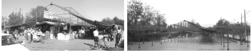
Fig. 83 Infraestructura edificada Feria modelo “Juan Pinto Durán”, Macul. (2009). Fuente: Carmen Gloria Troncoso.
