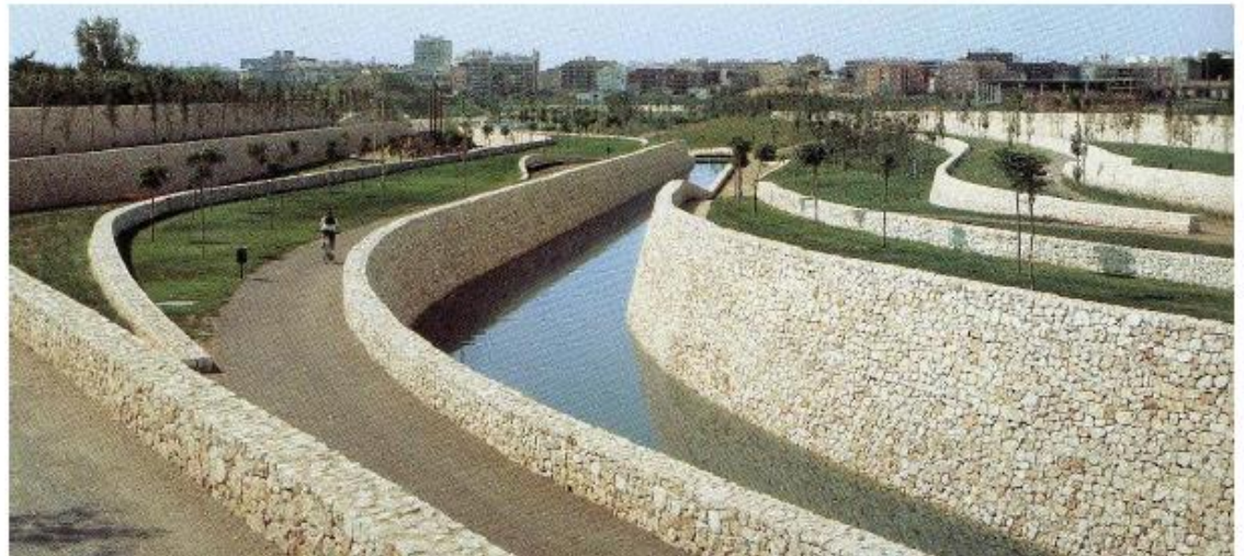
Parque inundable tipo on-line que mantiene volumen de agua permanente, Parque Cabecera, Valencia, España. (fuente: Arquitectura Viva N°103, 2005)
