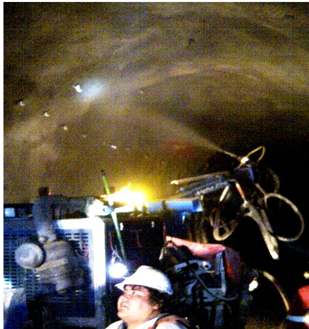
Figura 3.30: Shotcrete proyectado sobre la fibra sensora.
